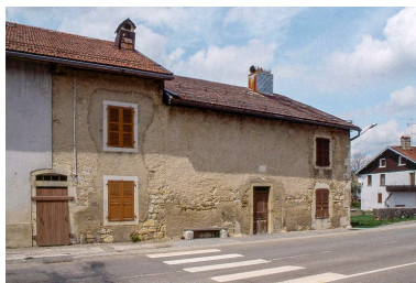
Ferme située rue du Faubourg. Phot. Yves Sancey IVR43_19993900258ZA
