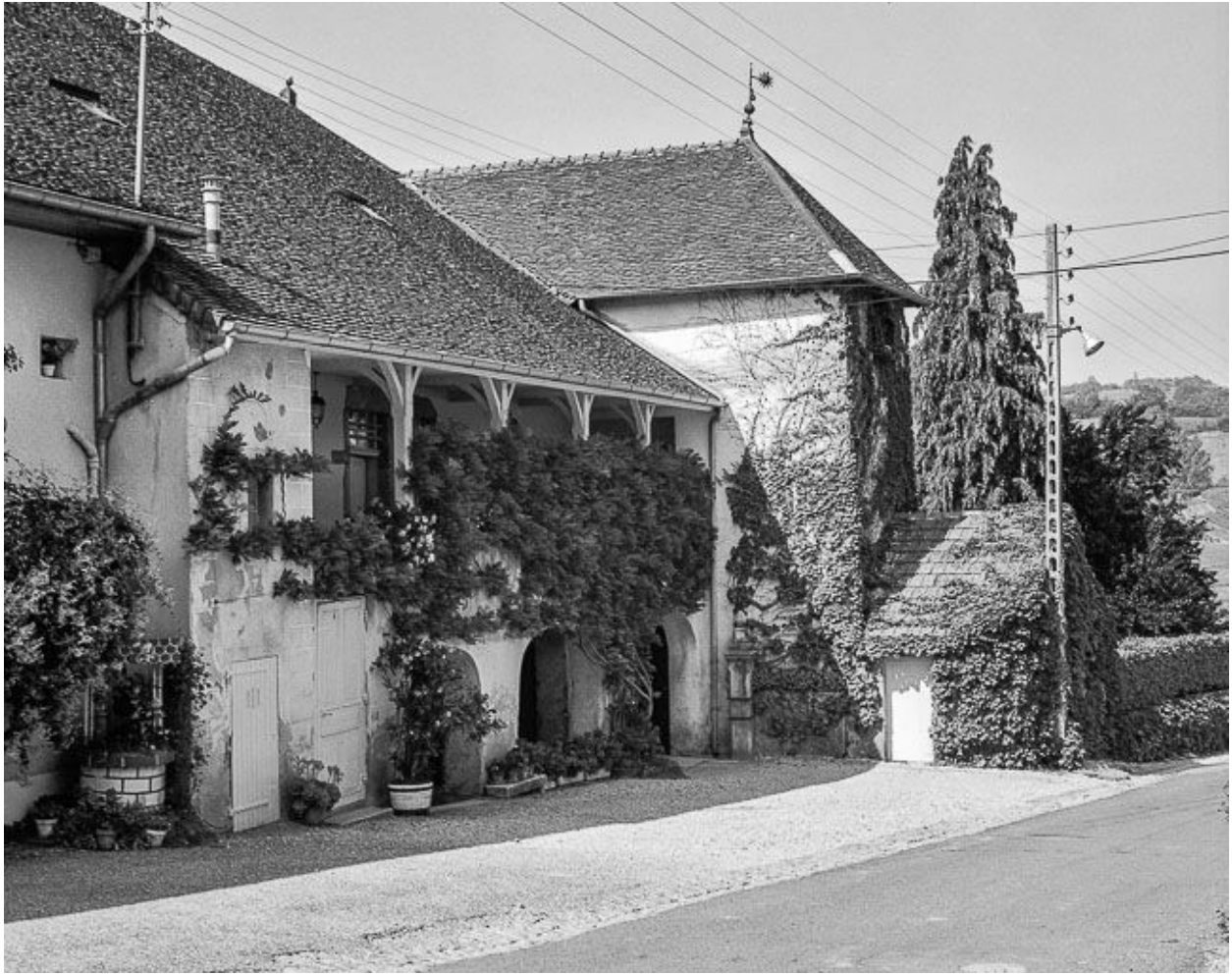
Maison de vigneron située rue de l'Eglise.
