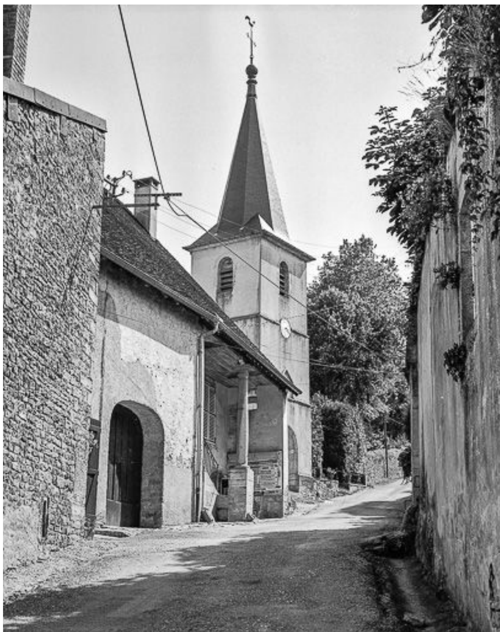
Maison de vigneron située rue de l'Eglise.
