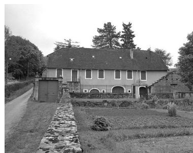
Maison de vigneron située rue de Farachat. Phot. Jérôme Mongreville IVR43_19853900183X
