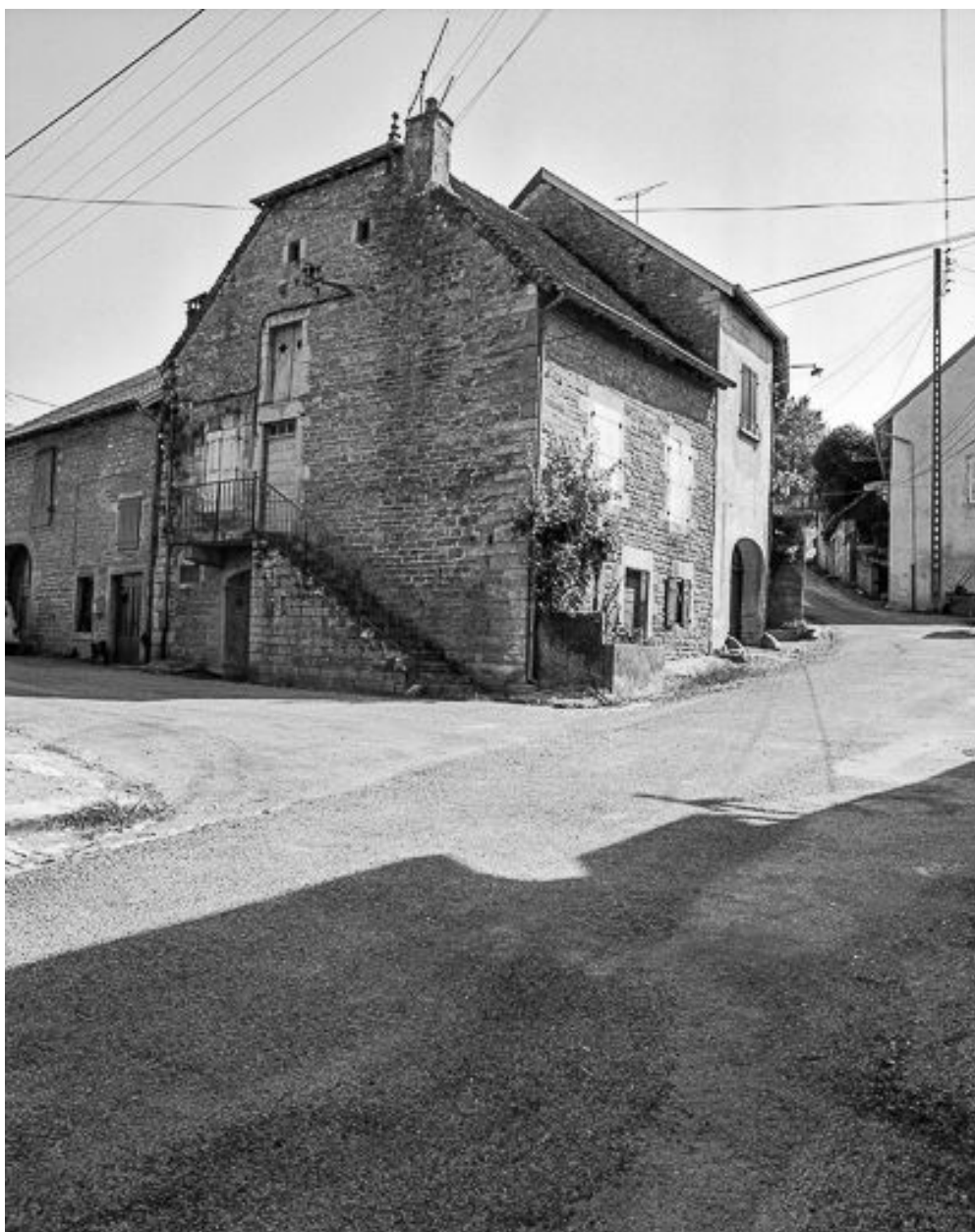
Maison de vigneron située rue de l'Eglise.
