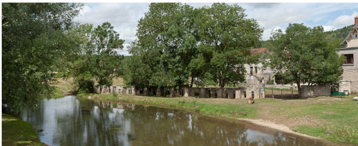
Vue du mur dit "évacuateur de crue".
