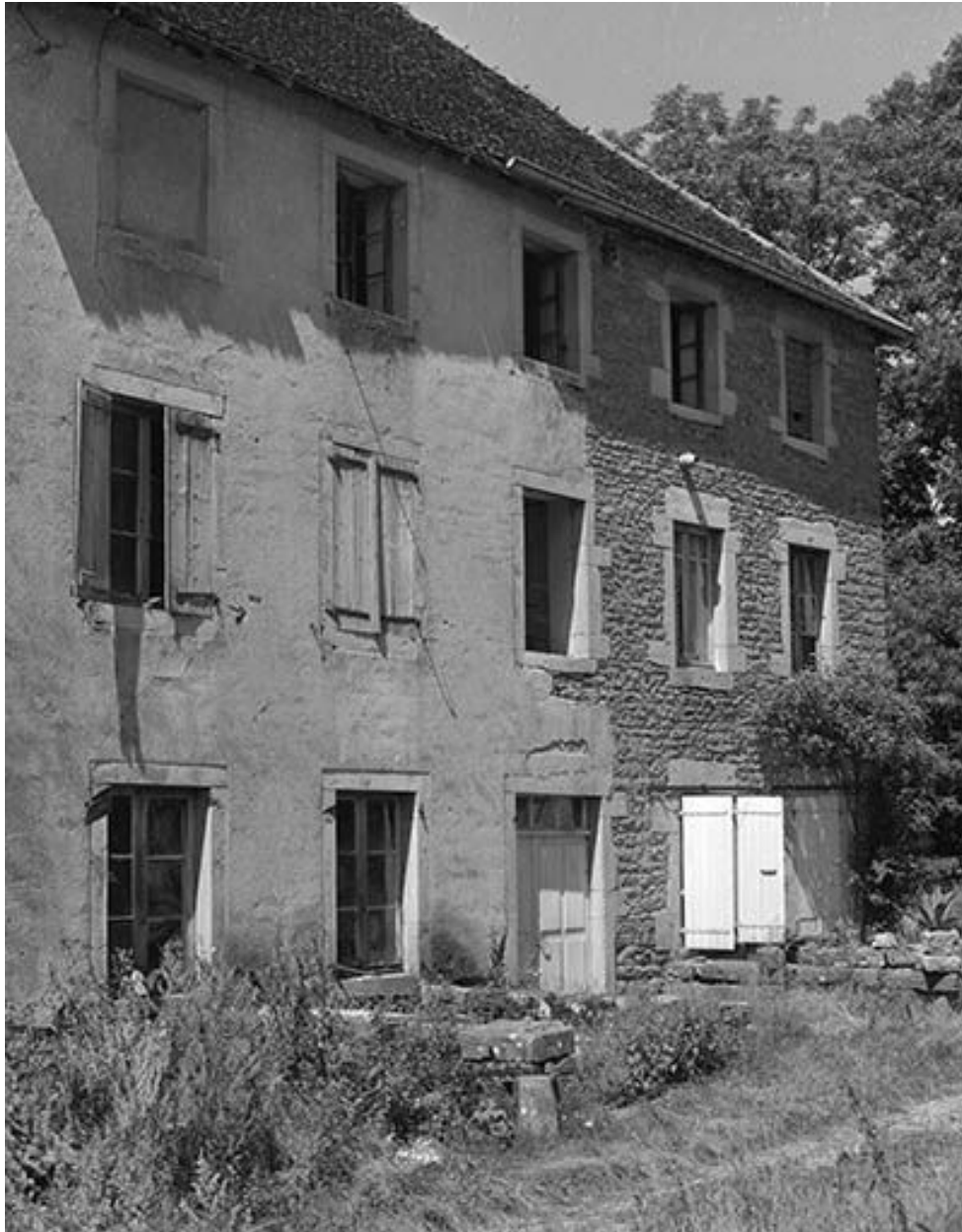
L'habitation : façade sur cour, détail.
