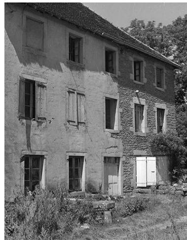
L'habitation : façade sur cour, détail. Phot. Yves Sancey IVR43_19803900118X
