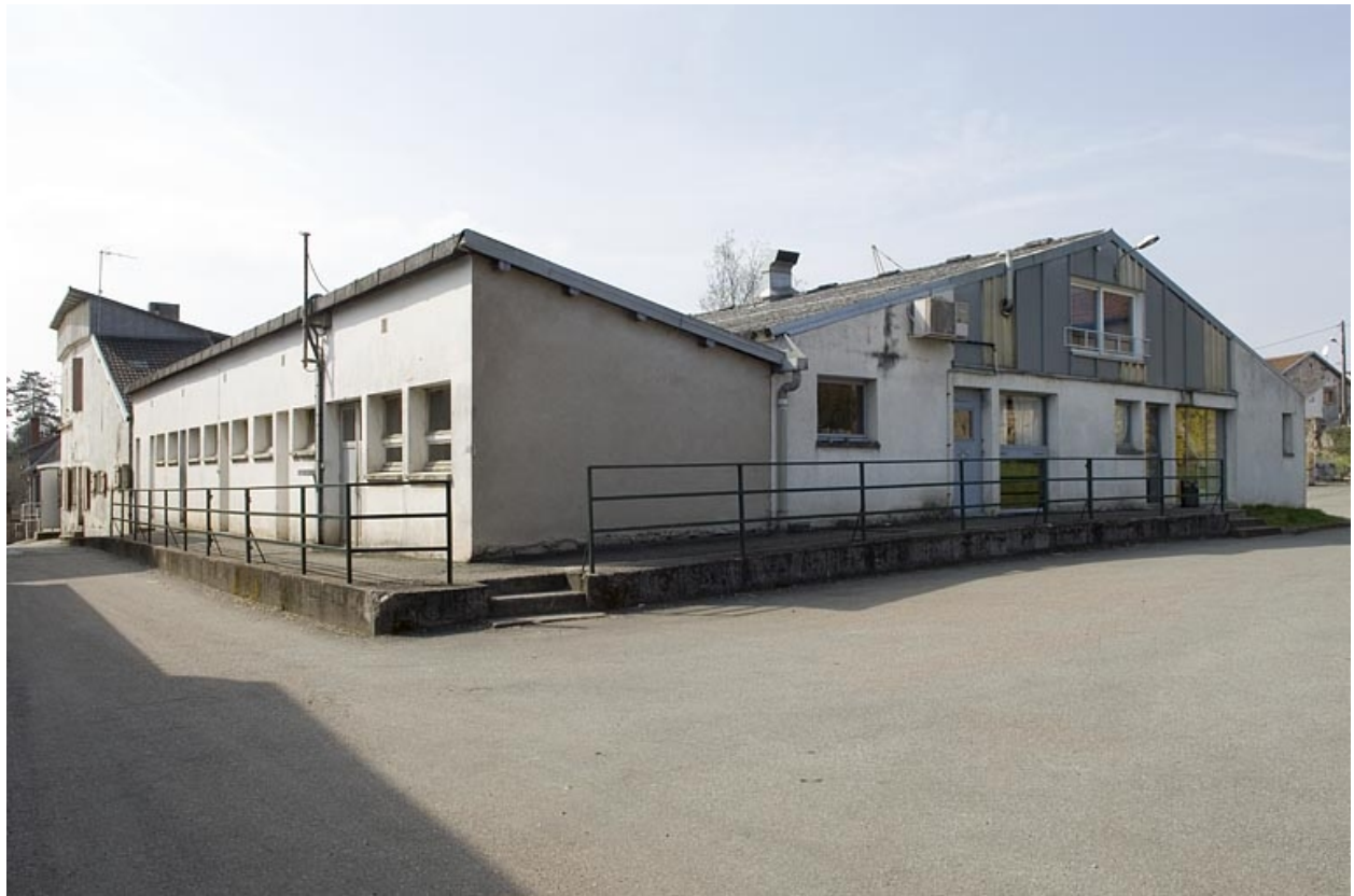
Vestiaires, bureau et atelier d'usinage.
