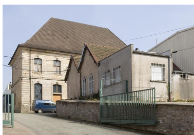
Bâtiment prieural et bureau depuis l'entrée. Phot. Jérôme Mongreville IVR43_20097000309NUC2A
