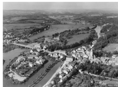
Vue aérienne depuis le sud-est. Phot. Jérôme Mongreville, Autr. Roger Henrard IVR43_20107000013NUC2A
