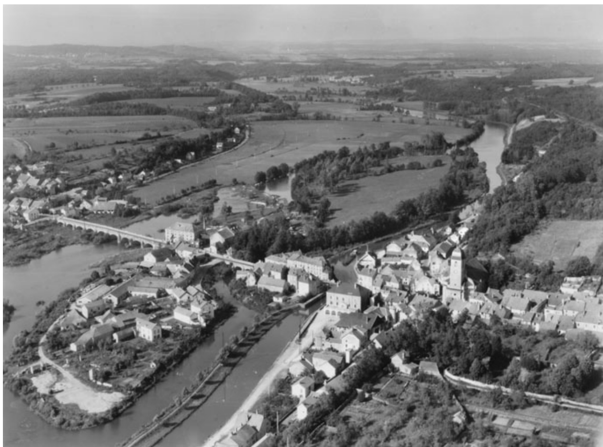
Vue aérienne depuis le sud-est.
