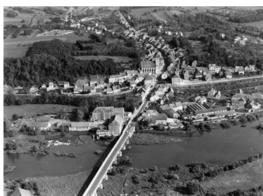
Vue aérienne depuis l'ouest. Phot. Jérôme Mongreville, Phot. Roger Henrard IVR43_20107000012NUC2A
