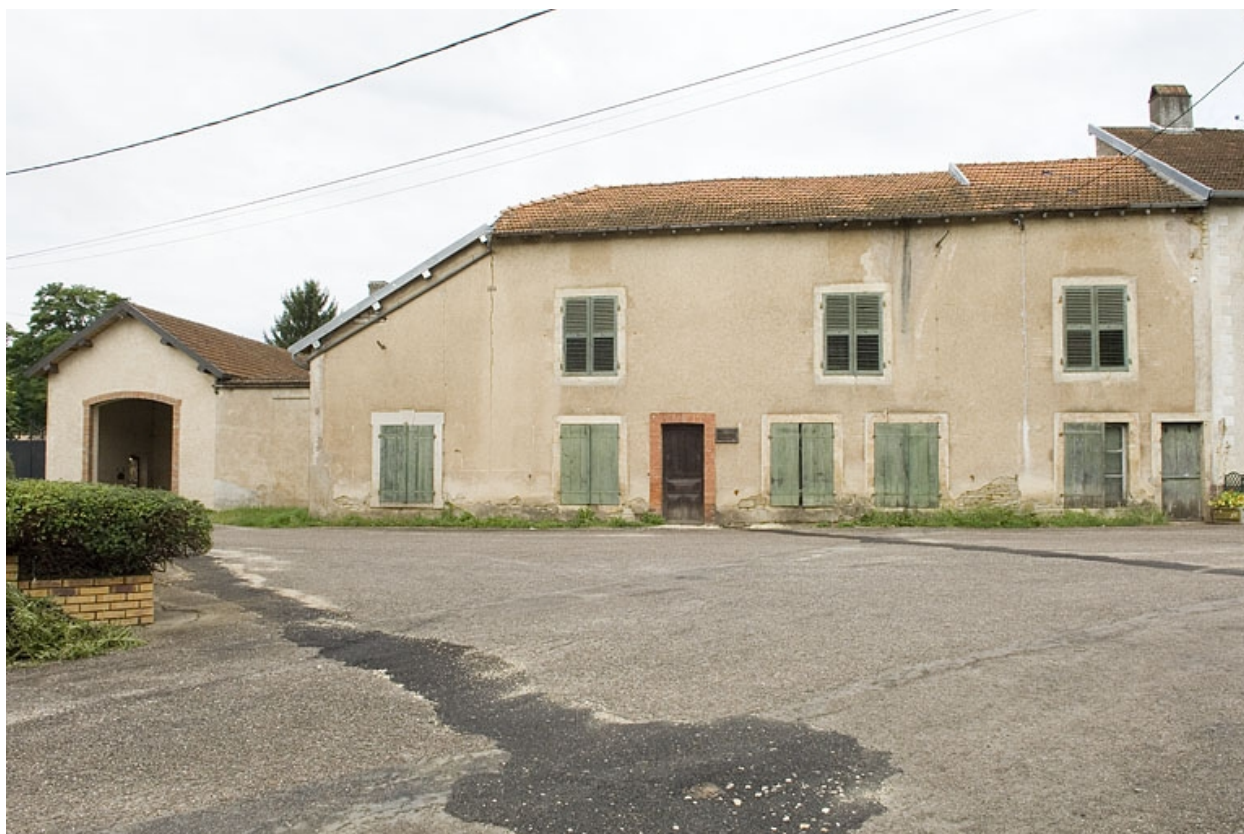
Vue du bâtiment d'entrée.
