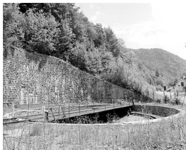
Tablier, fosse et chemin de roulement, depuis l'ouest. Phot. Yves Sancey IVR43_20033900965X
