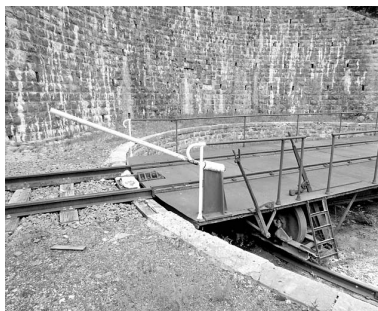
Barre permettant de faire pivoter le pont. Phot. Yves Sancey IVR43_20033900966X
