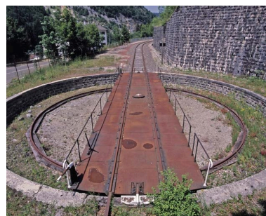
Tablier, fosse et chemin de roulement. Phot. Yves Sancey IVR43_20033900961XA
