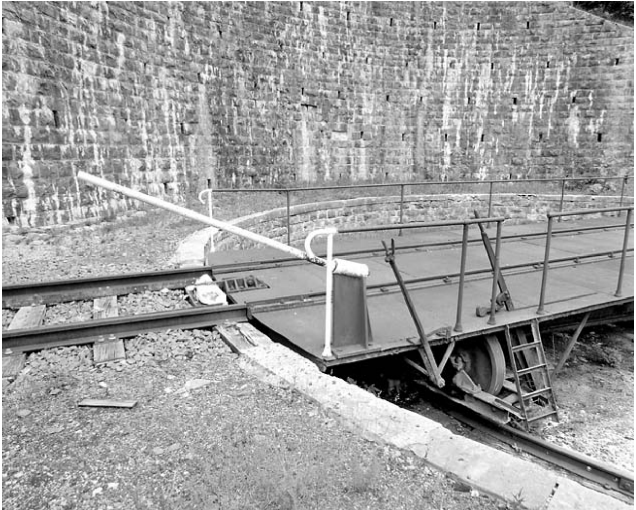
Barre permettant de faire pivoter le pont.
