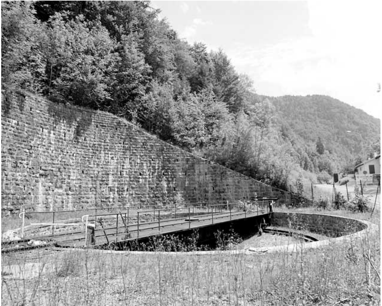
Tablier, fosse et chemin de roulement, depuis l'ouest.
