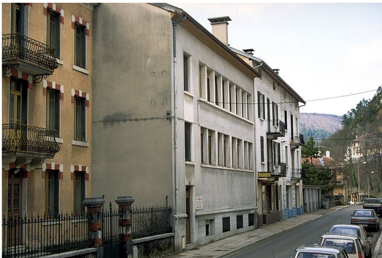
Vue d'ensemble, route de Genève.
