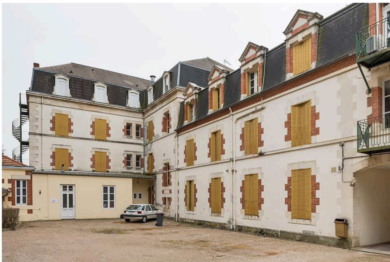
Façade sur la cour.
