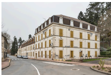
Façade sur l'avenue, vue en direction du nord-ouest. Phot. Pierre-Marie Barbe-Richaud IVR26_20227100045NUC4A
