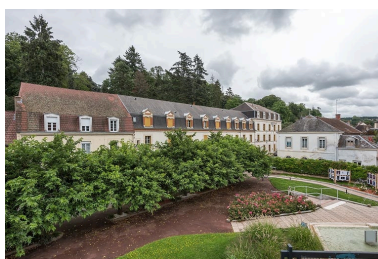
Toits brisés du bâtiment des services (en bitume) et de l'hôtel (en ardoise). Phot. Pierre-Marie Barbe-Richaud IVR26_20217100209NUC4A
