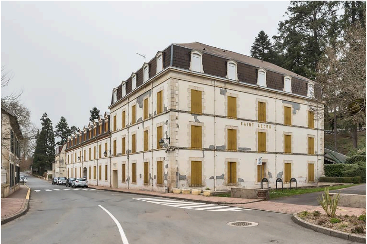
Façade sur l'avenue, vue en direction du nord-ouest.
