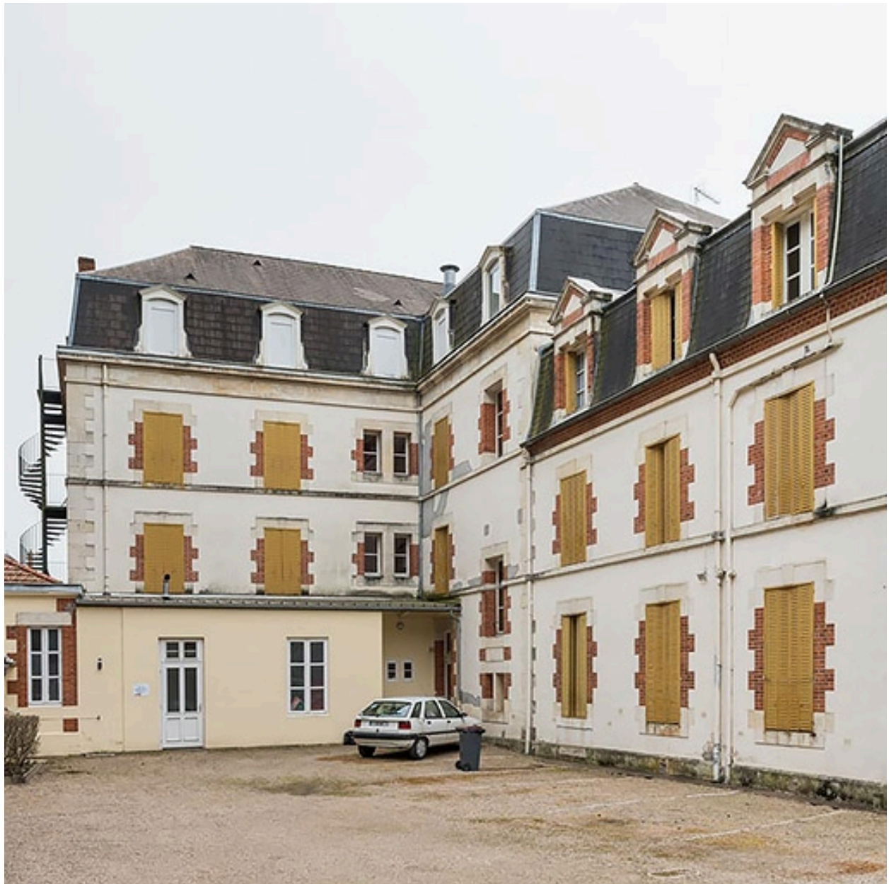
Façade sur la cour.
