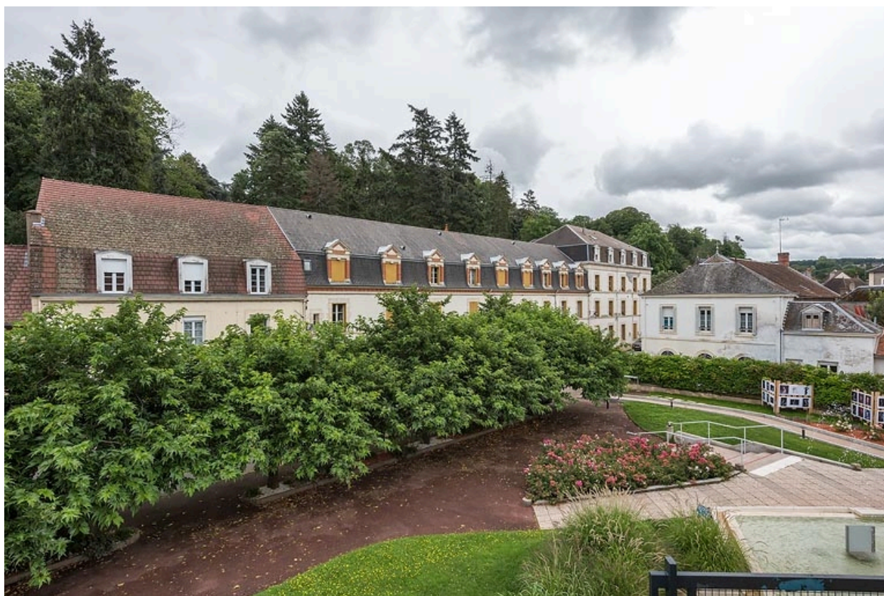
Toits brisés du bâtiment des services (en bitume) et de l'hôtel (en ardoise).
