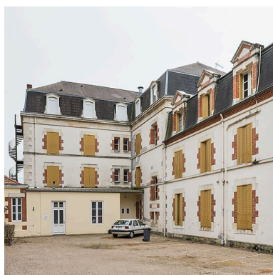
Façade sur la cour. Phot. Pierre-Marie Barbe-Richaud IVR26_20227100047NUC4A
