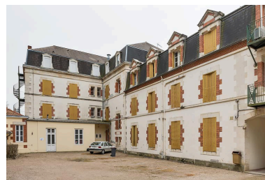
Façade sur la cour. Phot. Pierre-Marie Barbe-Richaud IVR26_20227100046NUC4A
