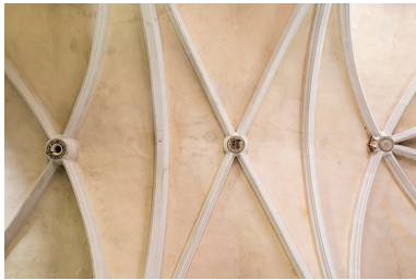
Vue de détail de la voûte en ogive et clés sculptées. Phot. Sonia Dourlot IVR43_20167001225NUC4A
