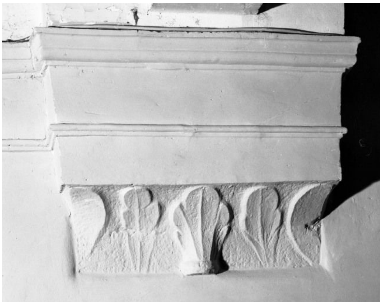
Nef, mur antérieur, pilastre gauche
