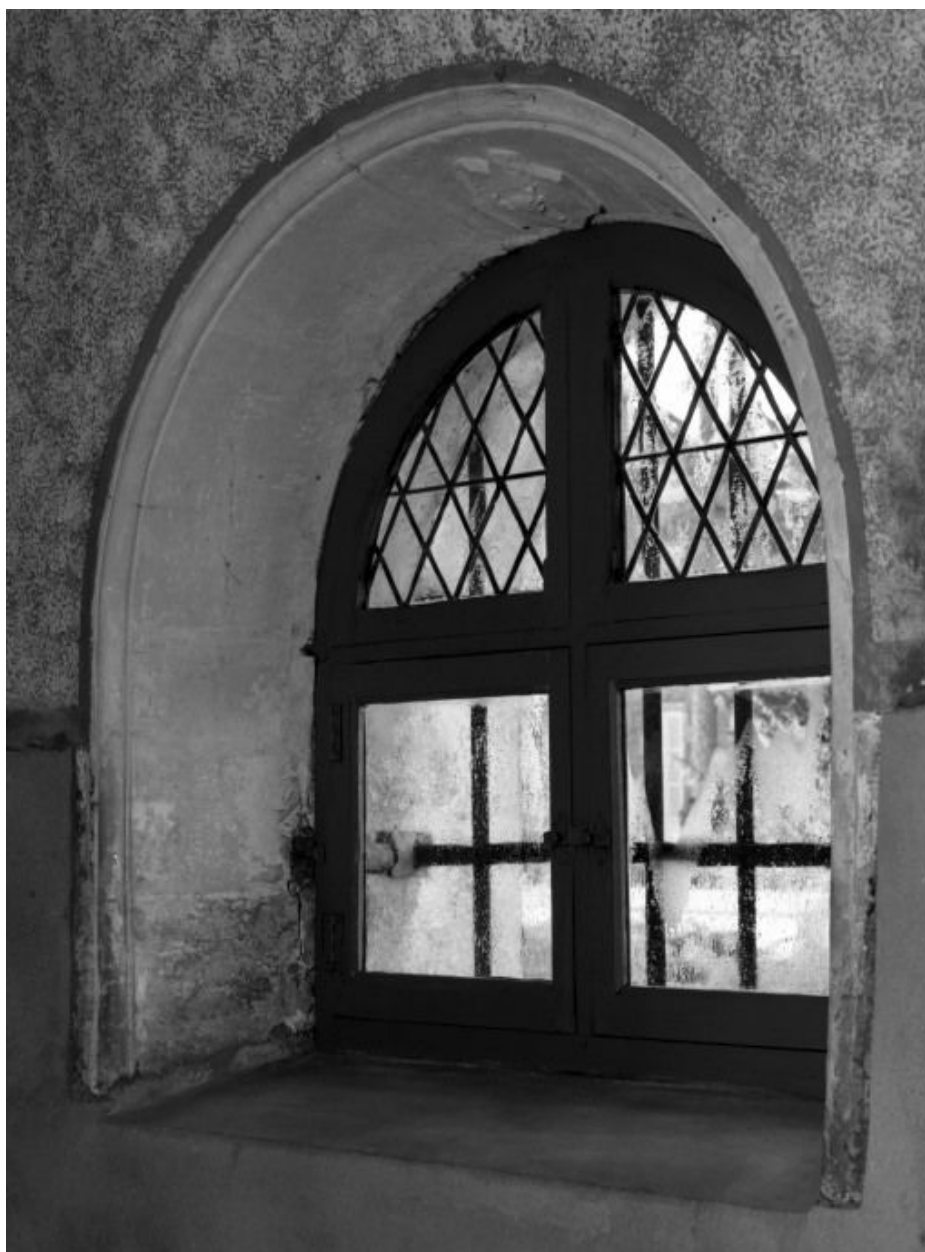
Sacristie, mur gauche, fenêtre
