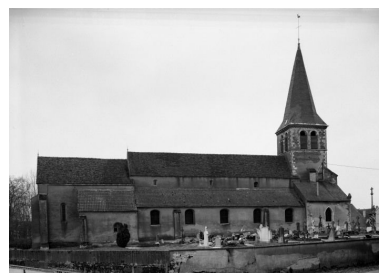
Elévation gauche Phot. Michel Rosso IVR26_19852101740V
