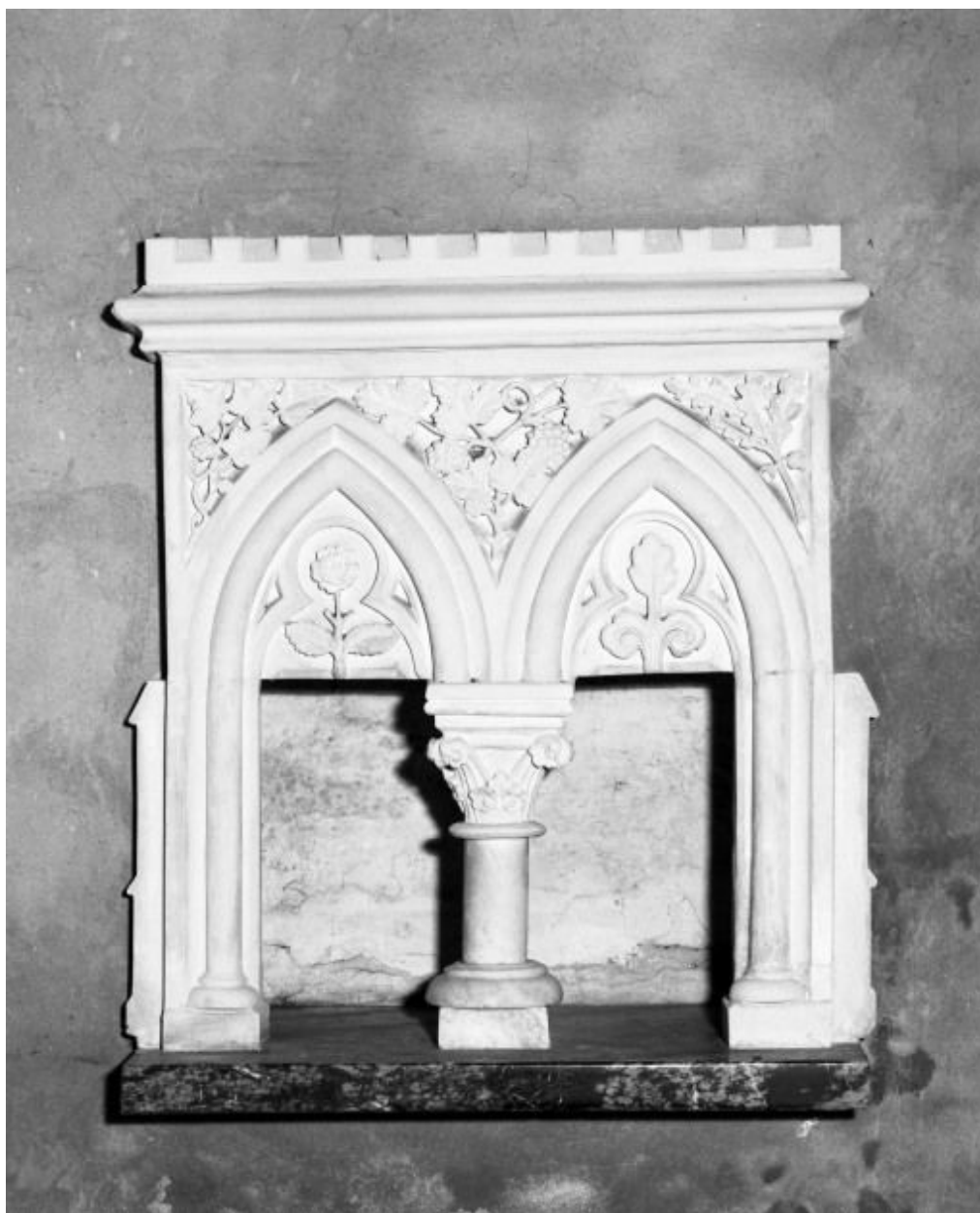
Choeur, 2e travée du mur droit, lavabo
