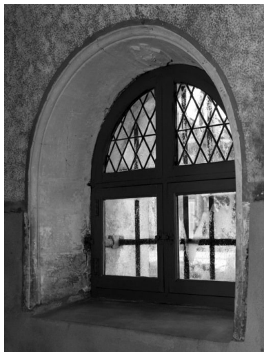
Sacristie, mur gauche, fenêtre Phot. Jean-Luc Duthu IVR26_19852101768X
