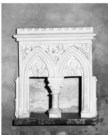
Choeur, 2e travée du mur droit, lavabo Phot. Jean-Luc Duthu IVR26_19852101767X
