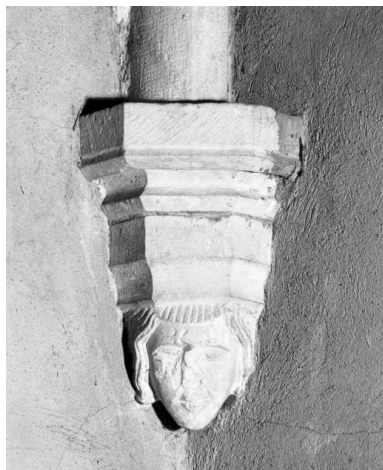
Choeur, 2e travée, culot postérieur droit Phot. Jean-Luc Duthu IVR26_19852101760X
