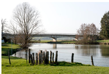
Vue depuis l'ancien départ du bac à Port d'Atelier. Phot. Sonia Dourlot IVR43_20167000317NUC4A
