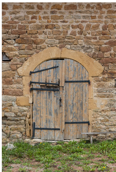
Porte de l'étable à gauche de la remise Phot. Pierre-Marie Barbe-Richaud IVR26_20197100415NUC4A
