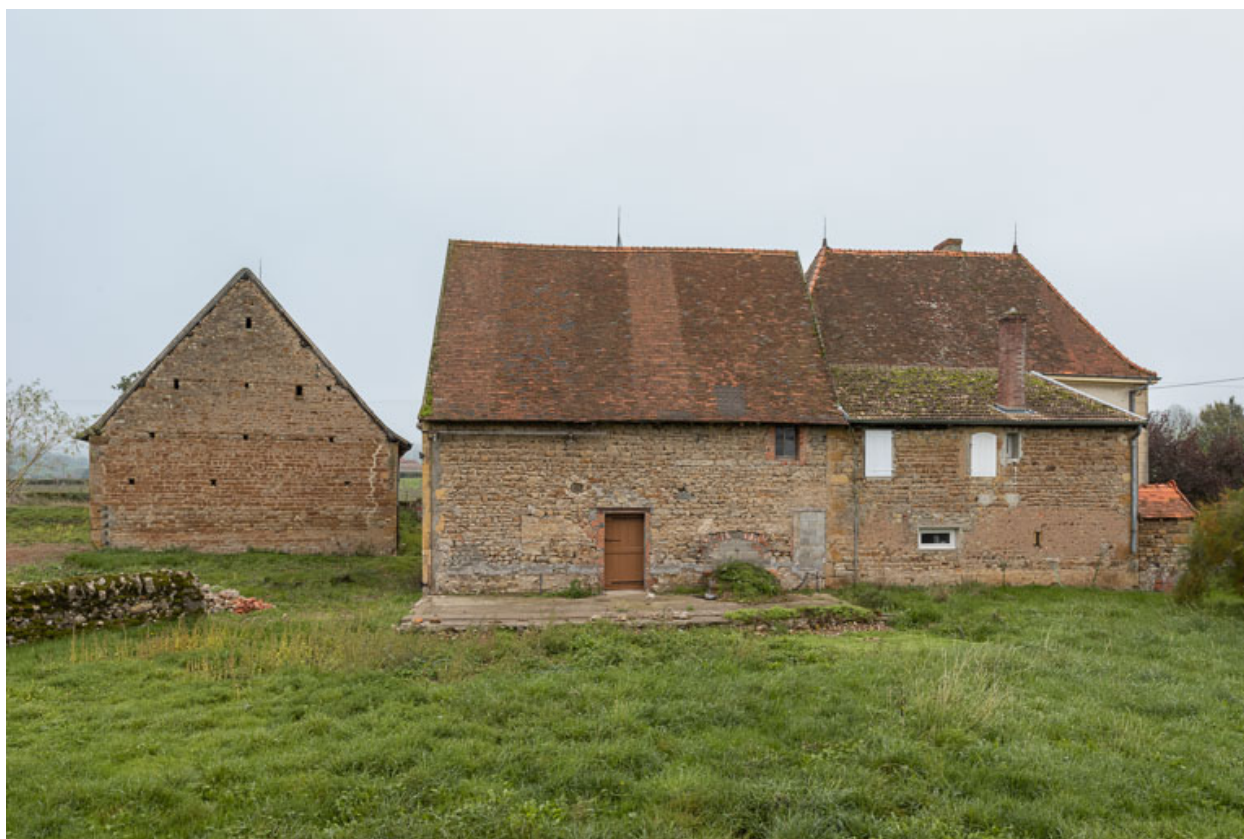
Vue de la façade postérieure de la maison et du cuvage. A gauche, le mur-pignon nord de la grange.
