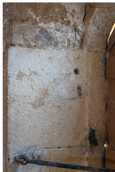
Embrasure de la porte de l'étable à gauche de la remise. L'emplacement des gonds de la porte d'origine est encore visible. Phot. Pierre-Marie Barbe-Richaud IVR26_20197100420NUC4A
