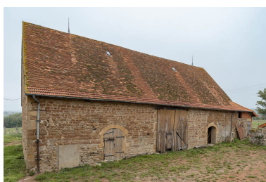
Façade antérieure de la grange Phot. Pierre-Marie Barbe-Richaud IVR26_20197100401NUC4A
