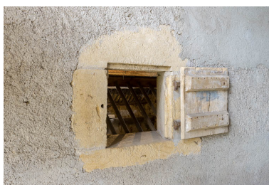
Feuron permettant de disposer le foin dans les rateliers depuis l'espace de la remise, où est placé le char. Phot. Pierre-Marie Barbe-Richaud IVR26_20197100418NUC4A
