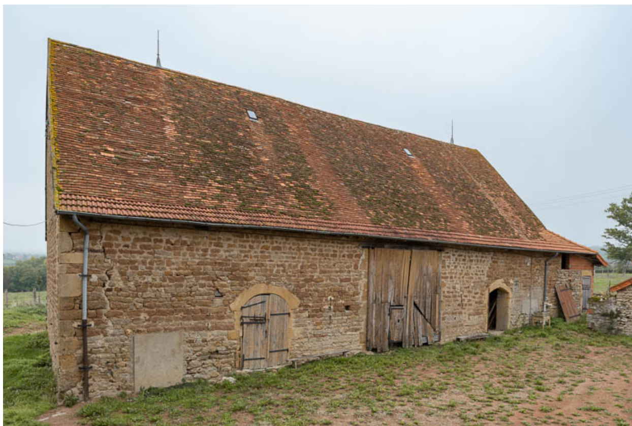
Façade antérieure de la grange
