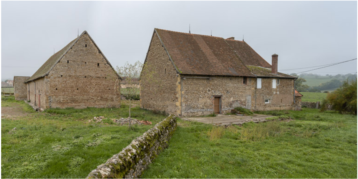
Vue de la façade postérieure de la maison et du cuvage, du mur-pignon nord et de la façade postérieure de la grange.
