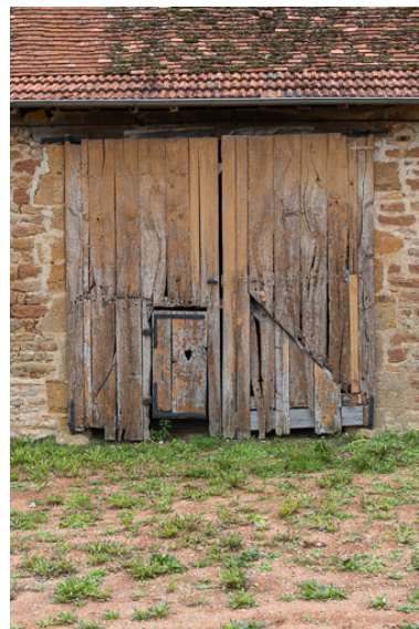
Ouverture principale de la grange : porte de la remise, où était placé le char à foin Phot. Pierre-Marie Barbe-Richaud IVR26_20197100417NUC4A
