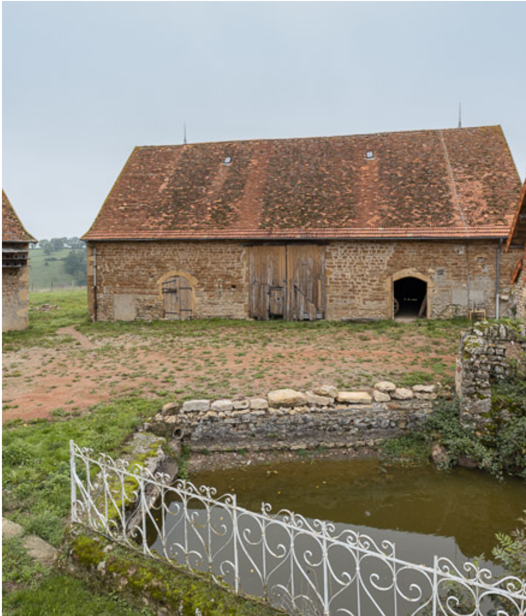
Vue de la façade postérieure de la grange. Au premier plan, la mare qui servait à l'abreuvement du bétail.
