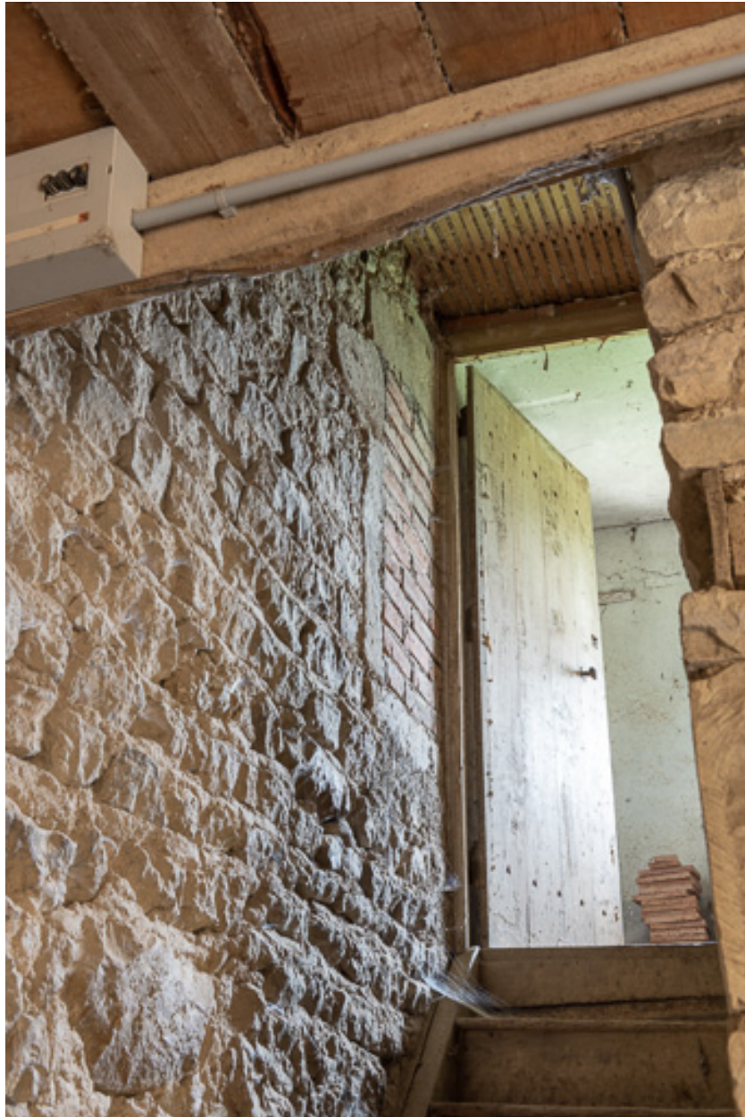
Vue de l'escalier et de la porte d'accès à la chambre de domestique, située au-dessus de la boulangerie. A gauche, une ancienne fenêtre bouchée suite à la construction du cuvage et du four à pain dans le premier quart du XIXe siècle.
