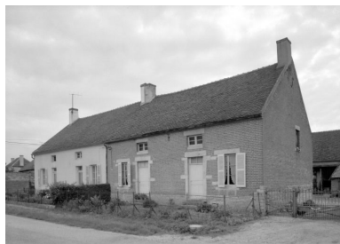
Logis (ferme cad. 1984, sect. AC, parc. 29-30). Phot. Michel Rosso IVR26_19862100604V
