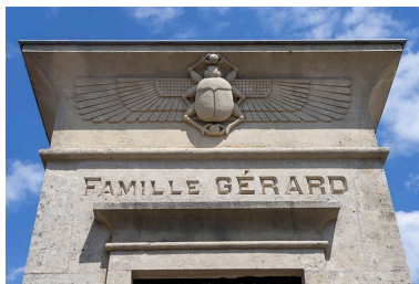
La corniche du tombeau. Phot. Jérôme Mongreville IVR43_20217000273NUC4A
