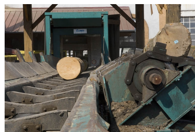
Admission d'une grume pour écorçage. Phot. Jérôme Mongreville IVR43_20067000473NUCA
