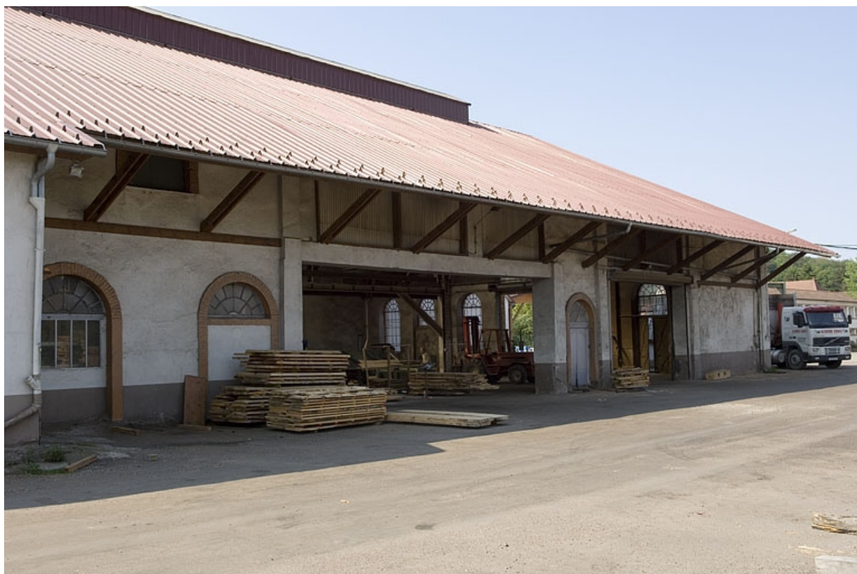
Façade nord de l'atelier de fabrication.
