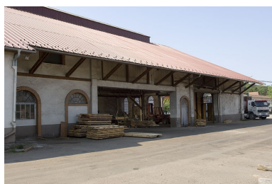
Façade nord de l'atelier de fabrication.
