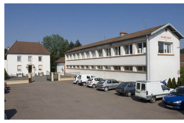
Logement patronal et bureaux. Phot. Jérôme Mongreville IVR43_20067000467NUCA
