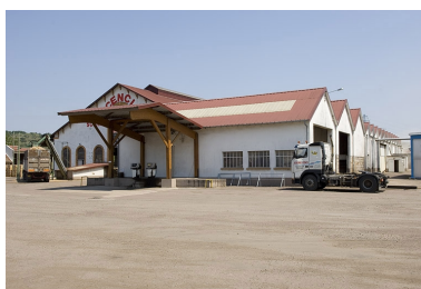
Ateliers de fabrication vus depuis le sud-ouest. Phot. Jérôme Mongreville IVR43_20067000480NUCA
