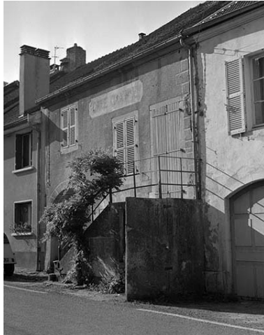
Façade antérieure, vue de trois quarts. Phot. Dominique Dominguez IVR43_19803900184X
