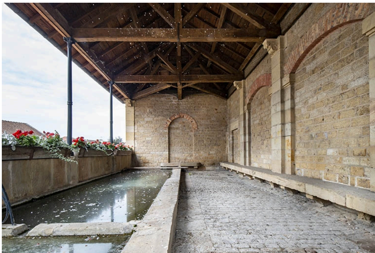
L'intérieur de la fontaine-lavoir, depuis l'entrée.
