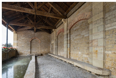
L'intérieur du lavoir en biais, depuis l'entrée. Phot. Jérôme Mongreville IVR43_20217000523NUC4A
