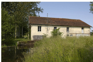
Façade antérieure. Phot. Jérôme Mongreville IVR43_20057000230NUCA
