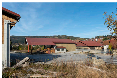
Ateliers de fabrication, depuis le sud-est. Phot. Sonia Dourlot IVR43_20182501735NUC4A
