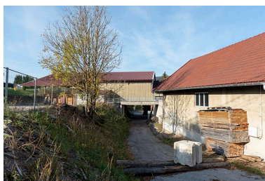
Atelier récent et chemin, depuis l'est. Phot. Sonia Dourlot IVR43_20182501734NUC4A
