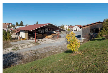
Ateliers de fabrication et magasin industriel, depuis le sud-ouest. Phot. Sonia Dourlot IVR43_20182501738NUC4A
