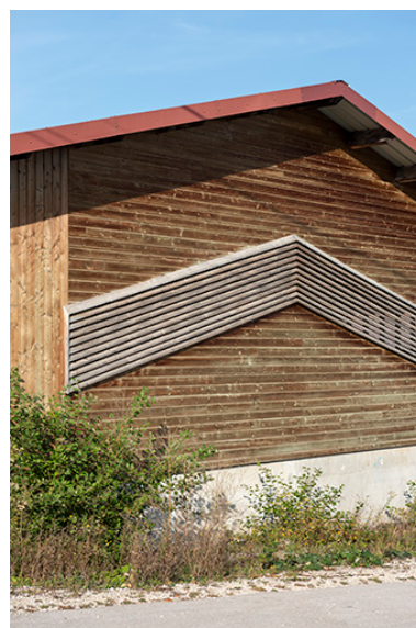
Magasin industriel : essentage de planches sur le mur est. Phot. Sonia Dourlot IVR43_20182501737NUC4A
