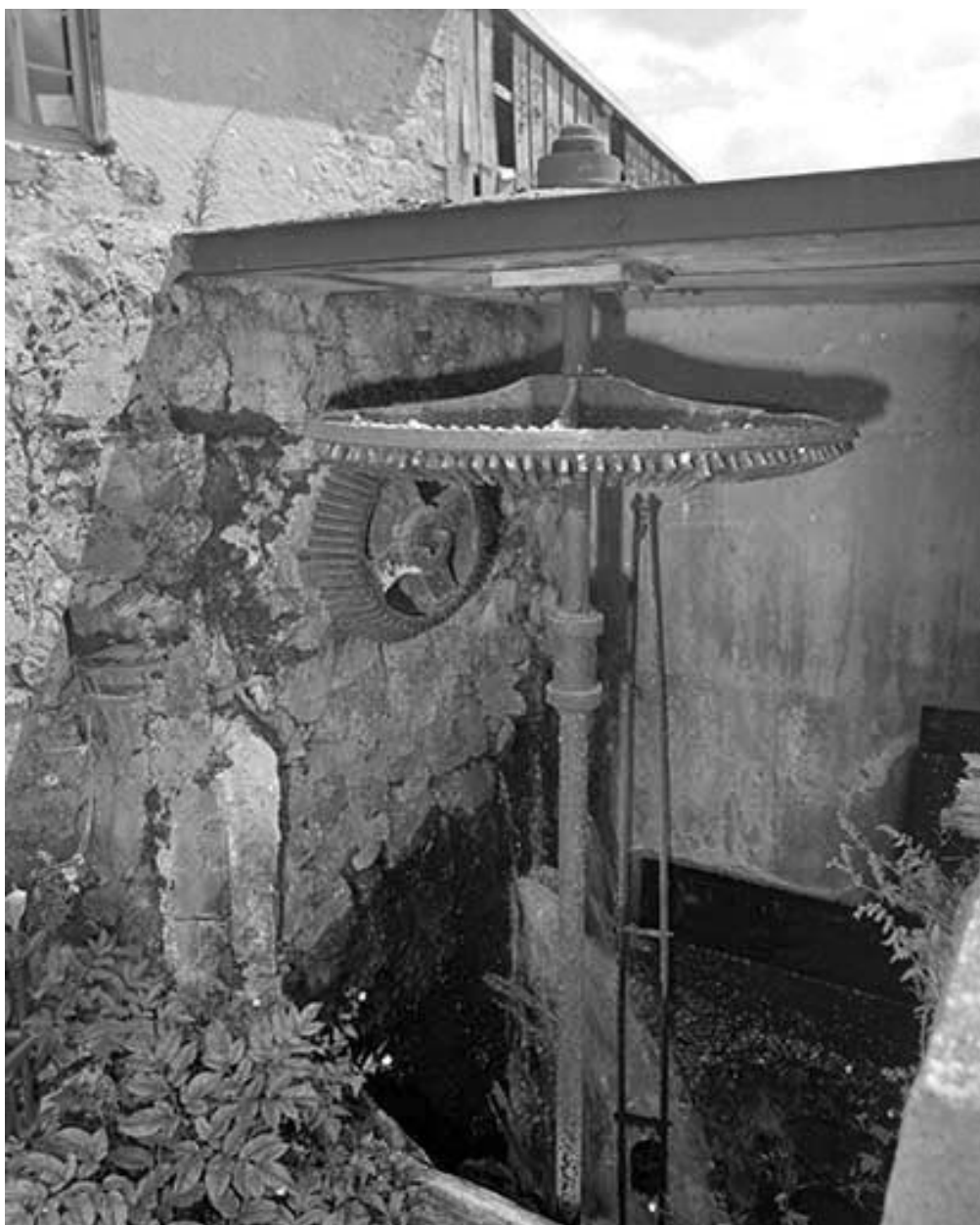
Système de roues hydrauliques, vue rapprochée.
