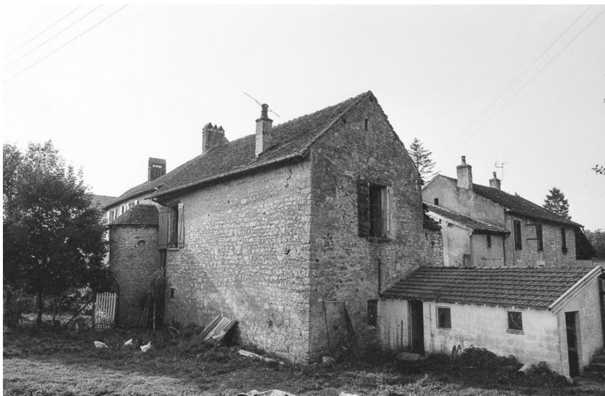
Façade latérale droite.
