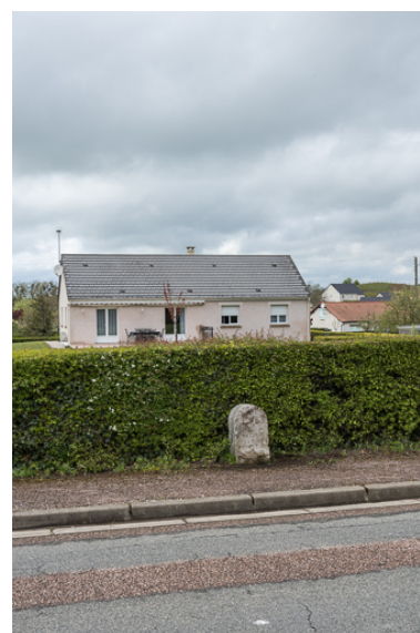
Borne périmétrique B (encore en place, rue du docteur Jean Pidoux) dans son environnement actuel. Phot. Pierre-Marie Barbe-Richaud IVR26_20195800257NUC4A
