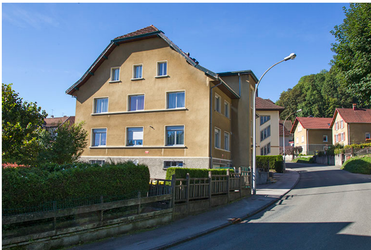
Façade latérale gauche, de trois quarts droite.
