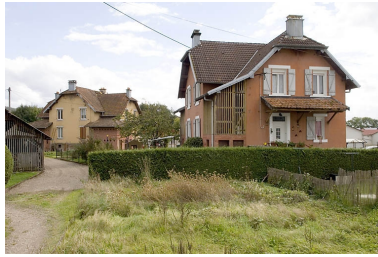
Maisons ouvrières à quatre logements. Phot. Jérôme Mongreville IVR43_20077000525NUCA
