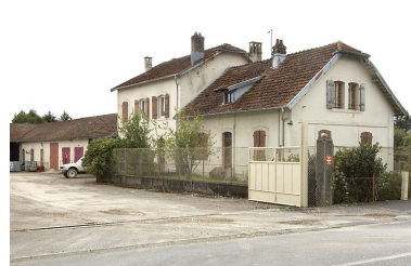
Entrepôt industriel et logements. Phot. Jérôme Mongreville IVR43_20077000521NUCA
