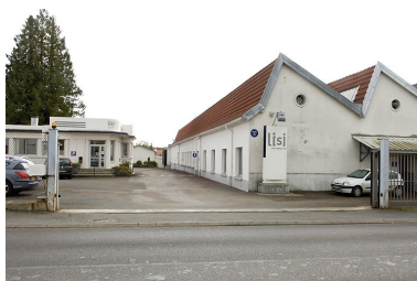
Entrée de l'usine. Phot. Jérôme Mongreville IVR43_20077000520NUCA
