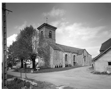
Vue de trois quarts droit. Phot. Yves Sancey IVR43_19853900184V
