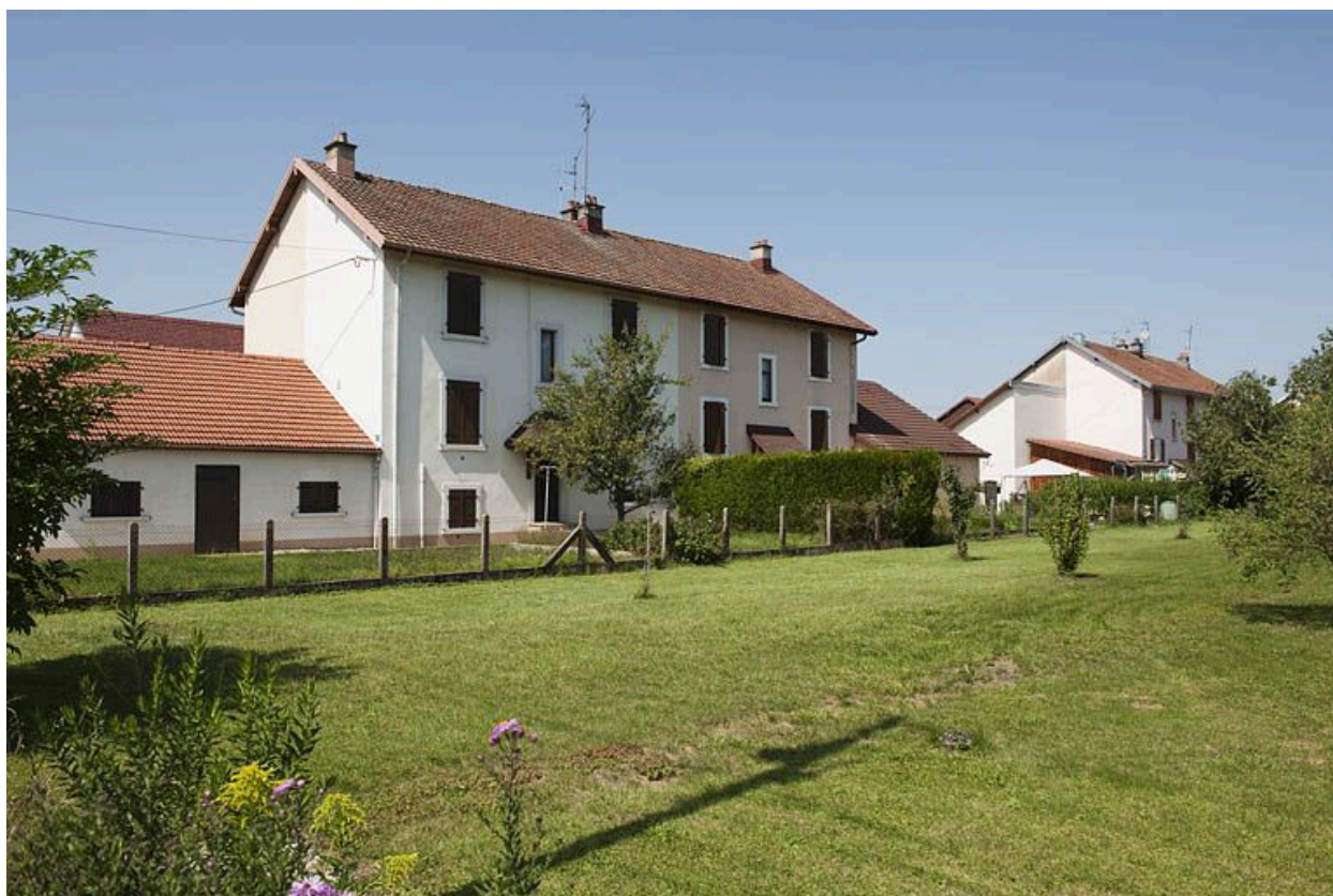
Façade postérieure des habitations.
