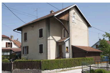
Maison jumelée vue de trois quarts. Phot. Jérôme Mongreville IVR43_20112502232NUC4A
