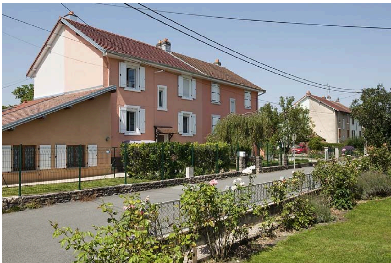
Façade antérieure des habitations.
