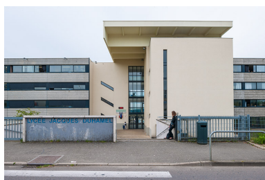
Entrée principale sur rue Charles Laurent Thouvery. Phot. Jérôme Mongreville IVR43_20143900181NUC4A
