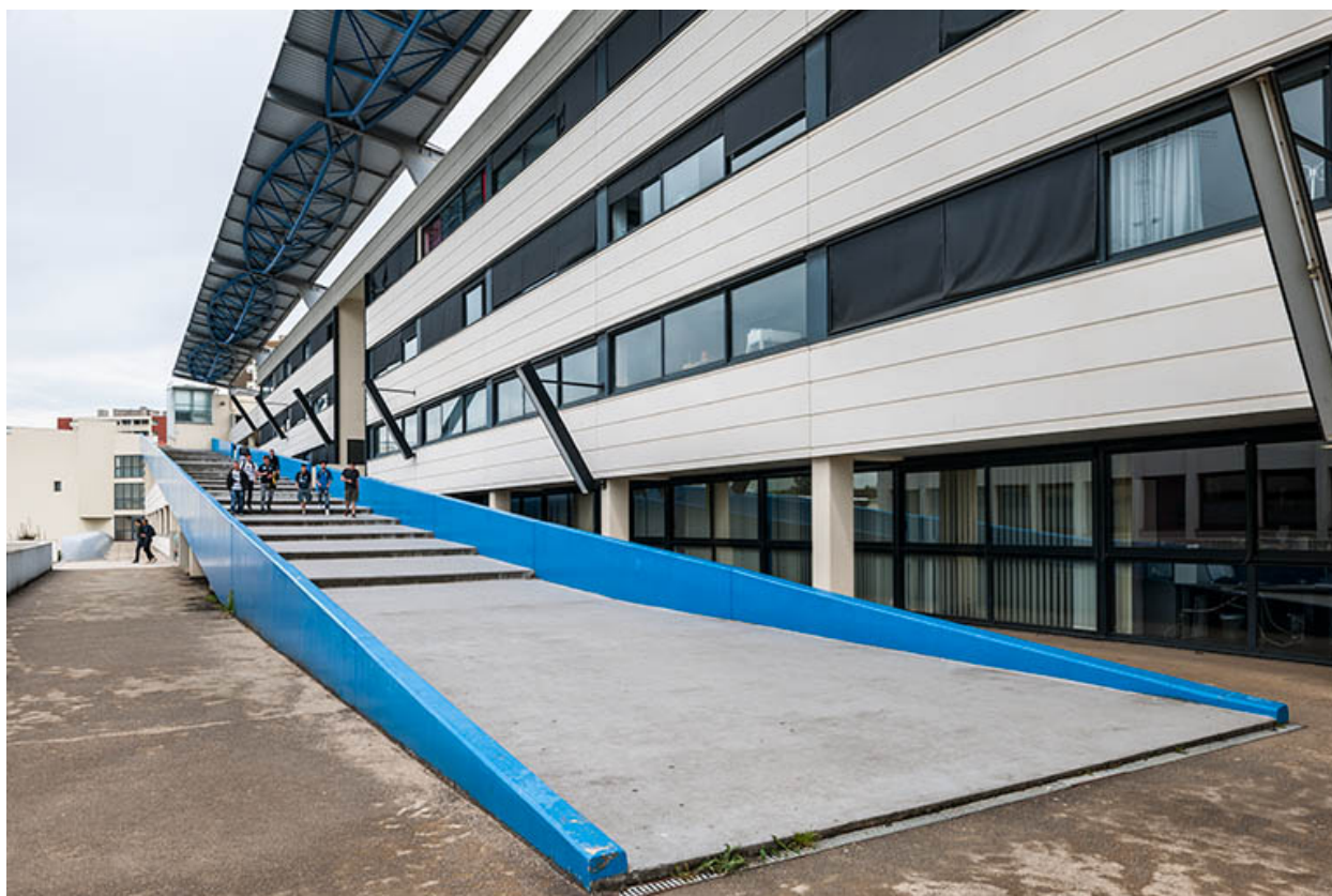
Externat, façade postérieure : rampe de secours.
