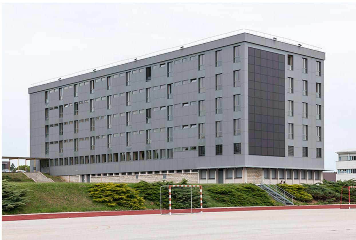
Internat : façade antérieure avec bardage et pignon sud avec panneaux photovoltaïques
