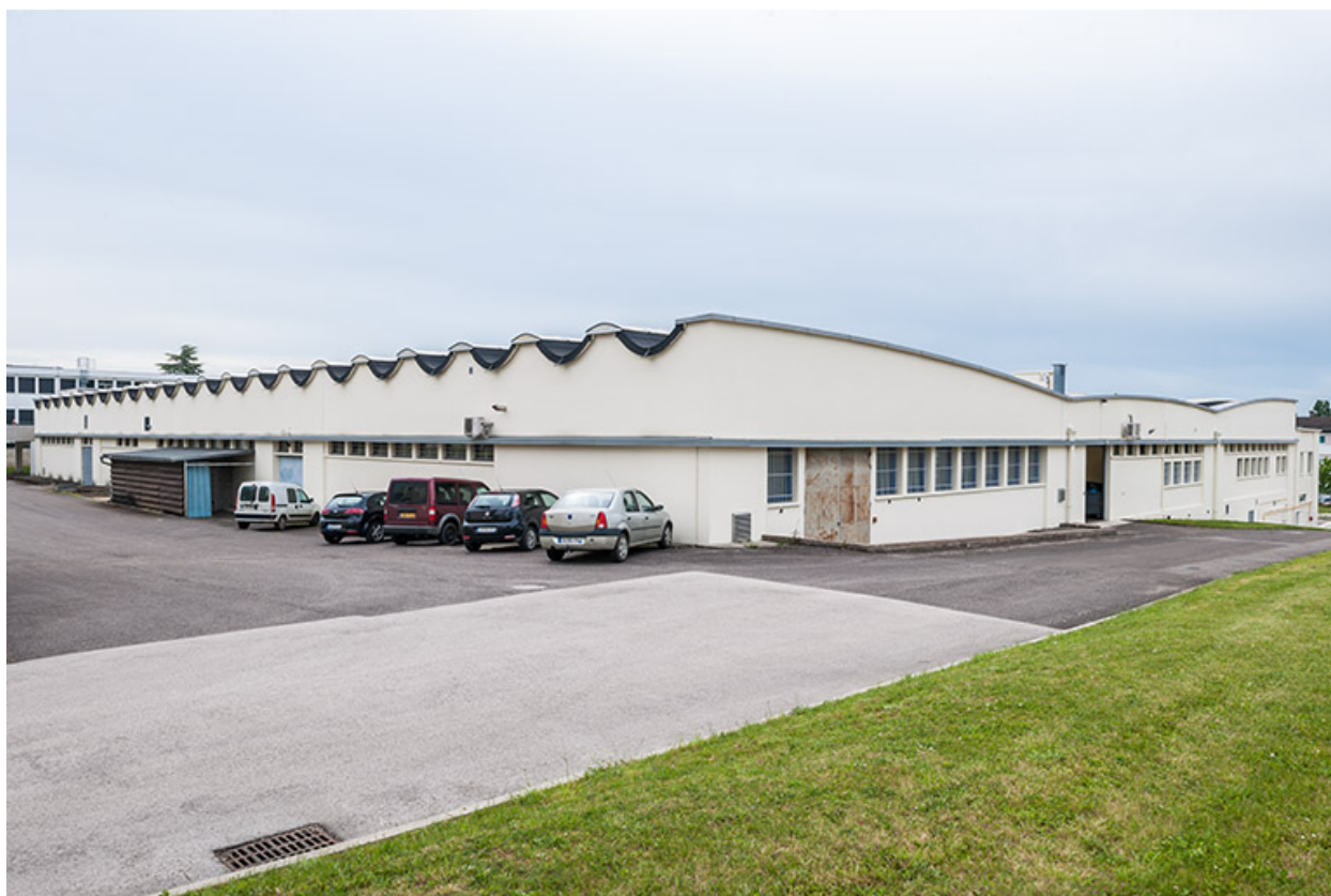
Ateliers : vue générale des façades arrière.
