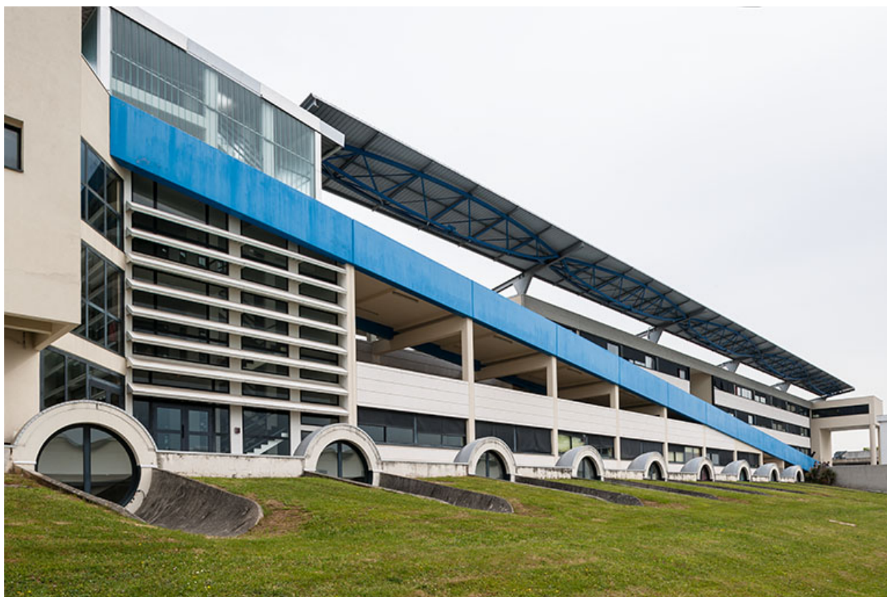
Bâtiment d'externat : façade antérieure.
