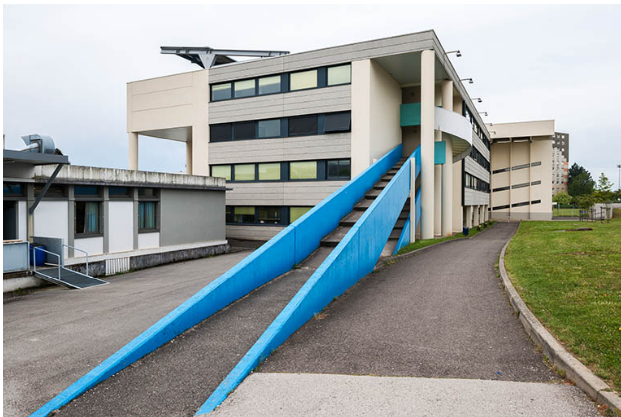
Bâtiment d'externat avec rampe d'accès.
