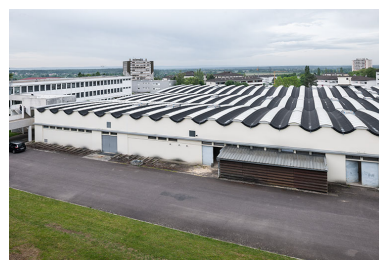
Ateliers : toitures Phot. Jérôme Mongreville IVR43_20143900196NUC4A
