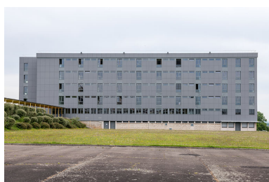
Internat : façade antérieure. Phot. Jérôme Mongreville IVR43_20143900203NUC4A
