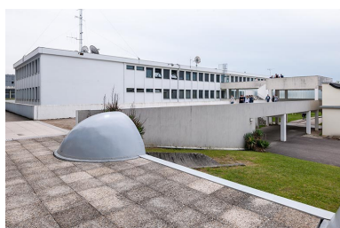
Externat : façade postérieure de l'ancien externat réaménagé. Phot. Jérôme Mongreville IVR43_20143900190NUC4A
