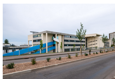
Externat : façade postérieure. Phot. Jérôme Mongreville IVR43_20143900180NUC4A
