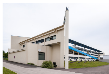
Bâtiment d'externat : pignon ouest. Phot. Jérôme Mongreville IVR43_20143900187NUC4A
