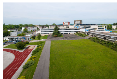
Vue générale depuis l'Est : 1er plan, installations sportives à droite, locaux de restauration, au fond ancien externat et en contrebas locaux du GRETA. Phot. Jérôme Mongreville IVR43_20143900213NUC4A
