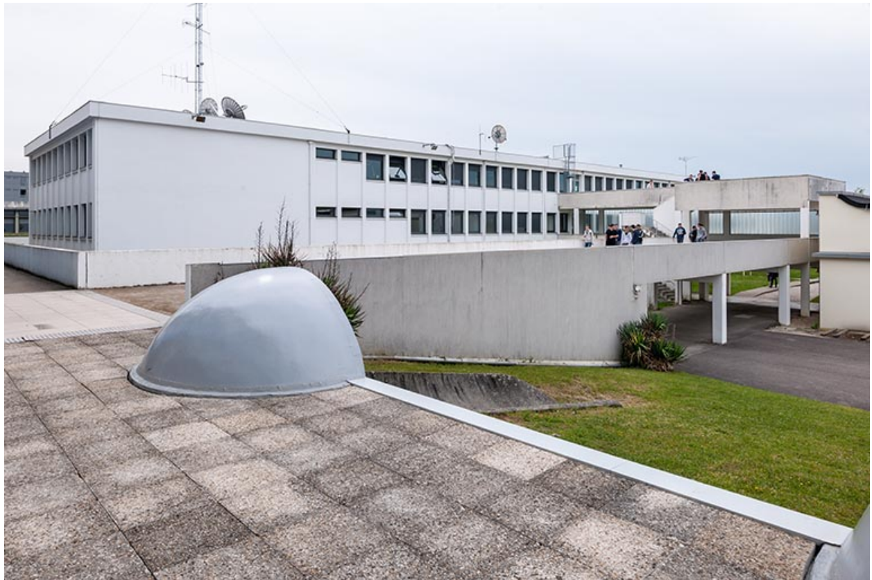
Externat : façade postérieure de l'ancien externat réaménagé.
