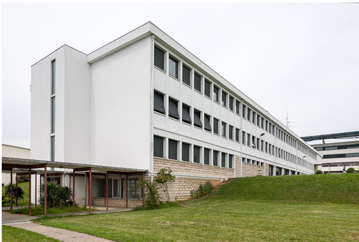
Externat : ancien bâtiment, pignon sud.
