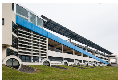
Bâtiment d'externat : façade antérieure. Phot. Jérôme Mongreville IVR43_20143900186NUC4A
