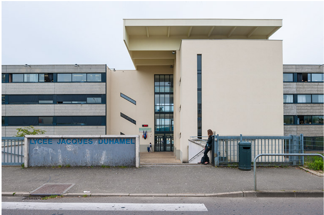
Entrée principale sur rue Charles Laurent Thouverey.
