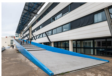
Externat, façade postérieure : rampe de secours. Phot. Jérôme Mongreville IVR43_20143900188NUC4A
