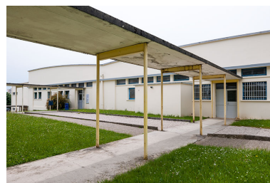
Passage couvert entre atelier et externat : détail. Phot. Jérôme Mongreville IVR43_20143900199NUC4A
