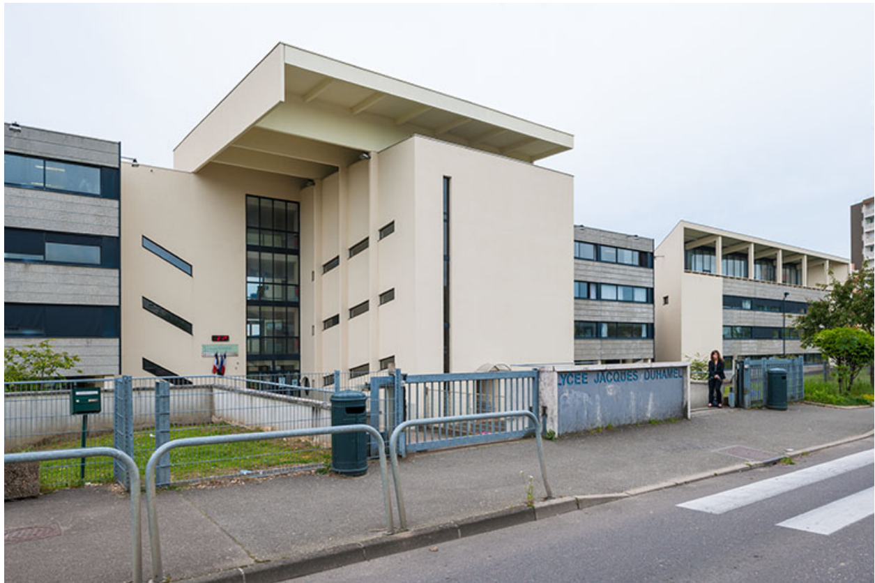
Entrée principale : détails.
