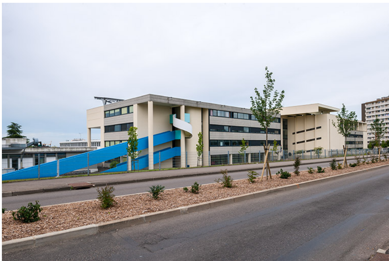
Externat : façade postérieure.
