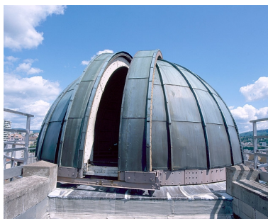
Le dôme ouvert. Phot. Yves Sancey IVR43_20032501125XA
