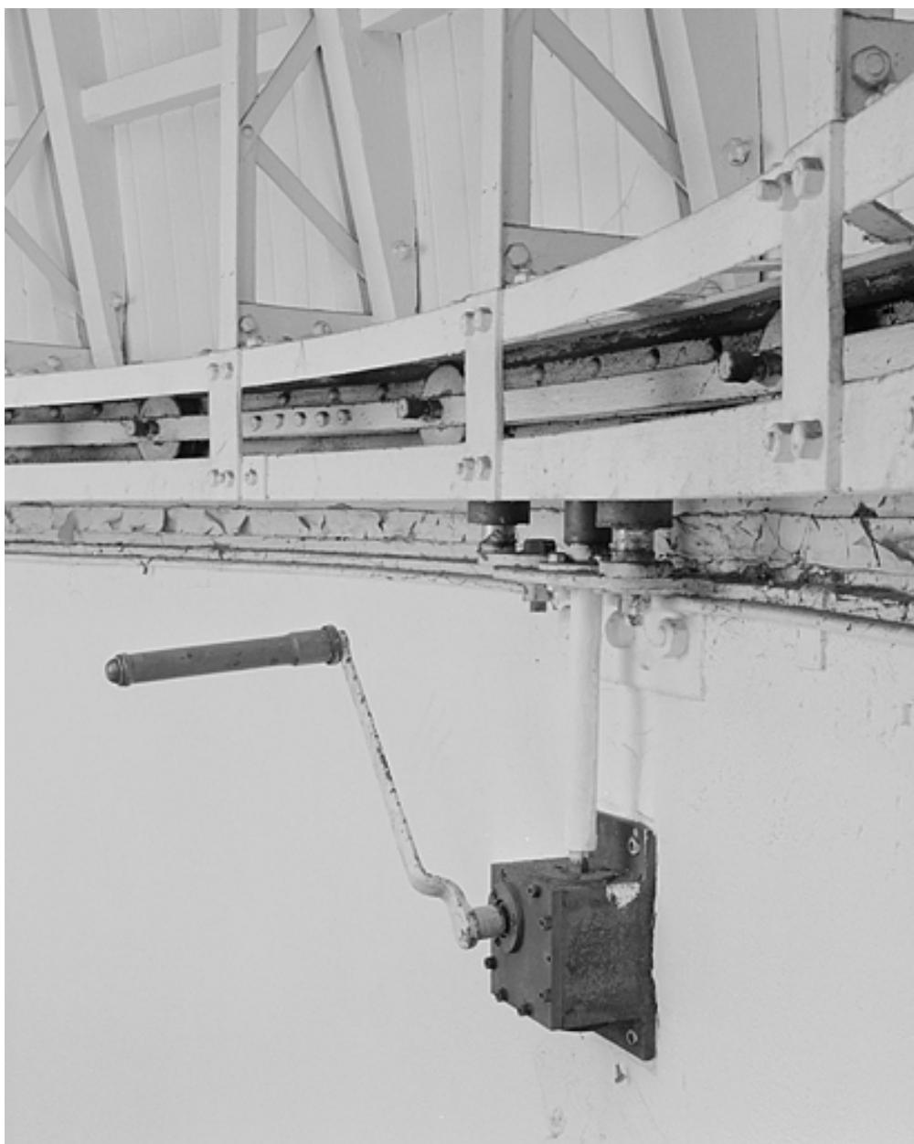
Système de rotation du dôme.
