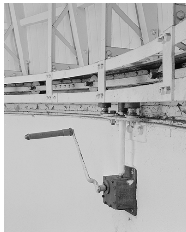
Système de rotation du dôme. Phot. Yves Sancey IVR43_20032501160X
