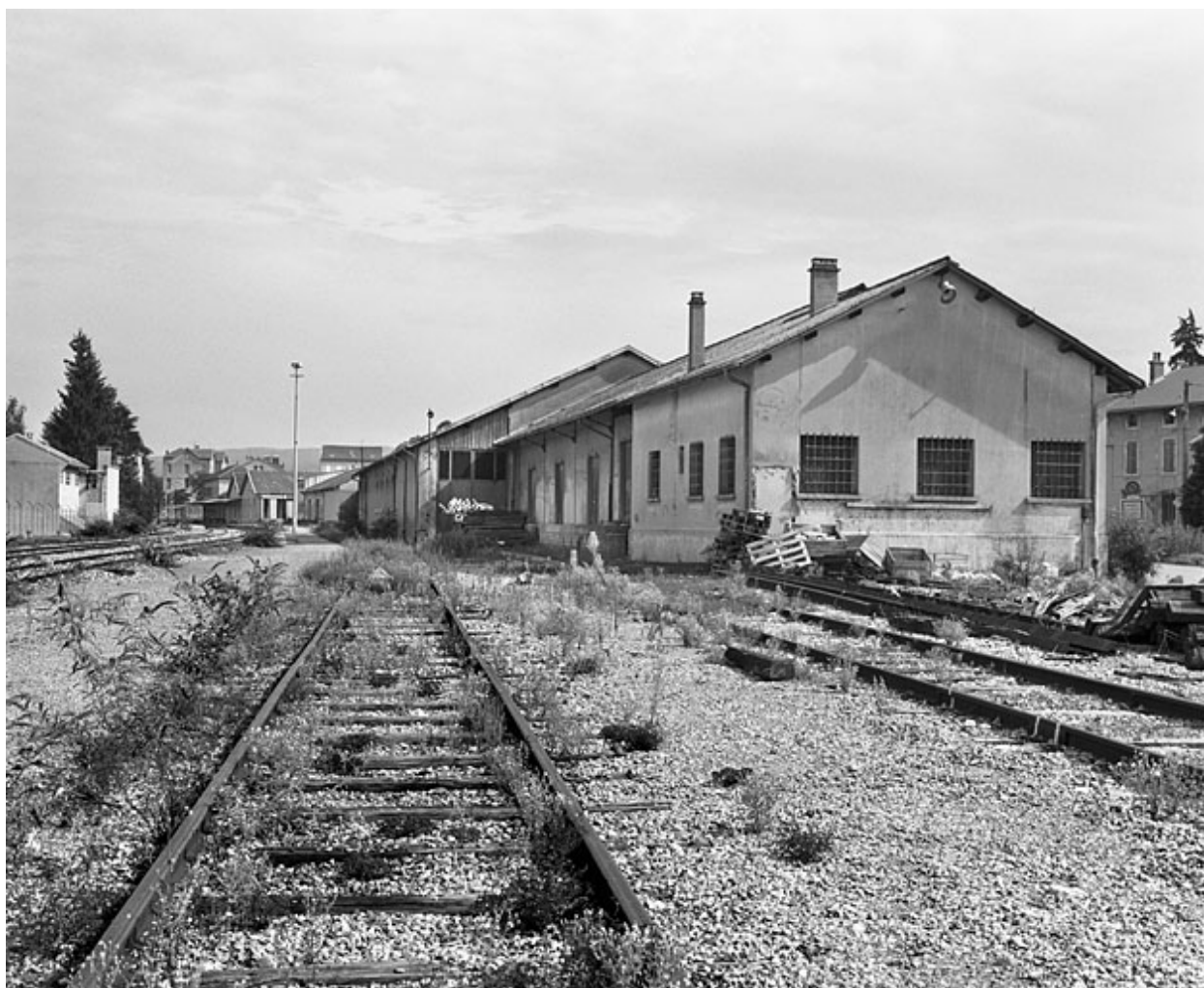
Entrepôts, depuis le sud-ouest (côté La Cluse).
