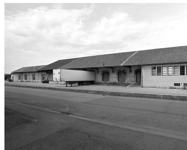
Entrepôts : façade antérieure, de trois quarts droite. Phot. Yves Sancey IVR43_20050100087X
