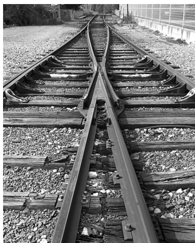
Appareil de voie (" aiguillage ") à l'extrémité de la gare, côté La Cluse (sud-ouest). Phot. Yves Sancey IVR43_20050100094X
