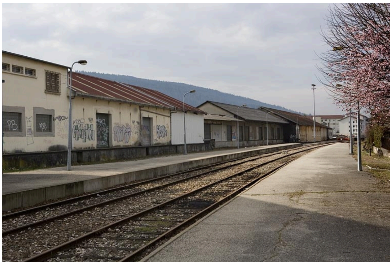
Entrepôts : façade postérieure (sur voies), de trois quarts gauche.
