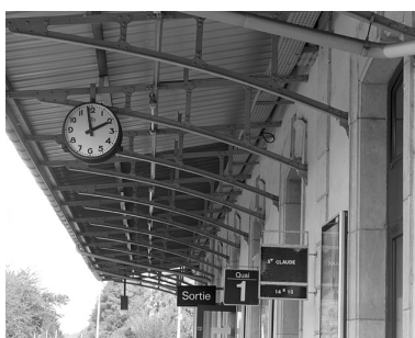
Bâtiment des voyageurs : consoles métalliques de l'auvent et horloge. Phot. Yves Sancey IVR43_20050100091X
