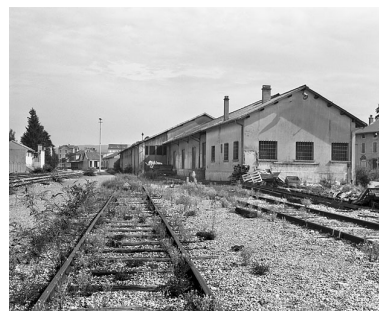
Entrepôts, depuis le sud- ouest (côté La Cluse). Phot. Yves Sancey IVR43_20050100088X
