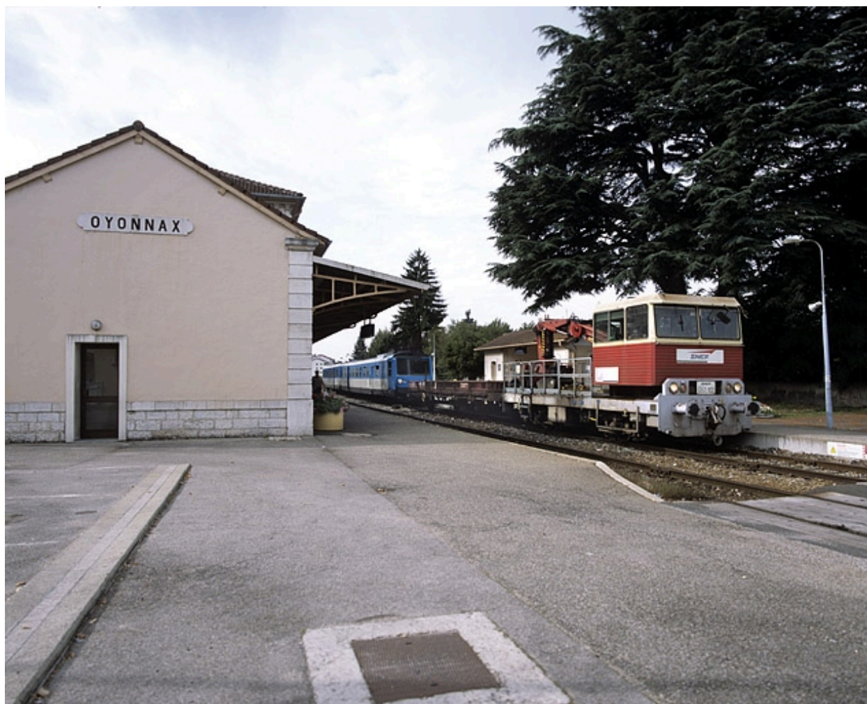
Bâtiment des voyageurs : extrémité nord, avec autorail RGP 1 (X 2733) et draisine.
