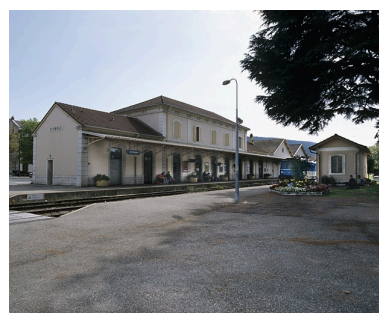
Vue d'ensemble, depuis le nord- ouest (côté Andelot-en-Montagne). Phot. Yves Sancey IVR43_20050100081XA
