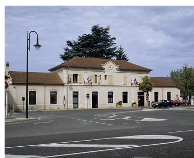
Bâtiment des voyageurs : façade antérieure, de trois quarts gauche. Phot. Yves Sancey IVR43_20050100077XA
