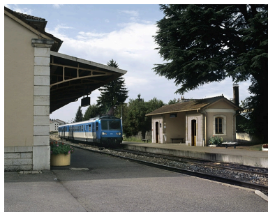
Abri de voyageurs - lampisterie et autorail RGP 1 (X 2733). Phot. Yves Sancey IVR43_20050100085XA
