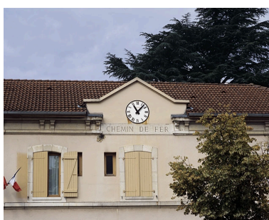
Bâtiment des voyageurs : fronton, avec inscription et horloge. Phot. Yves Sancey IVR43_20050100075XA
