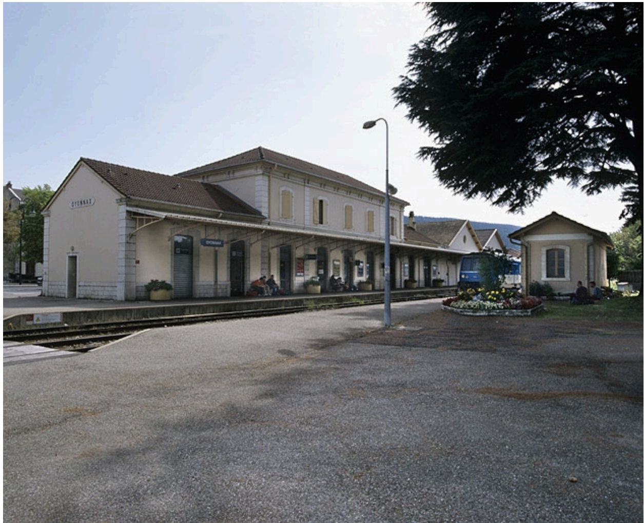
Vue d'ensemble, depuis le nord-ouest (côté Andelot-en-Montagne).
