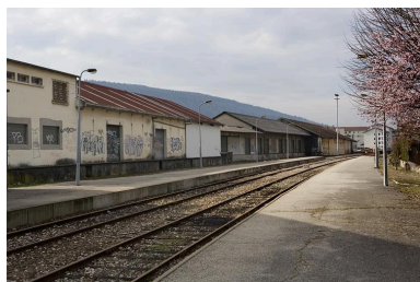
Entrepôts : façade postérieure (sur voies), de trois quarts gauche. Phot. Yves Sancey IVR43_20070100002NUCA
