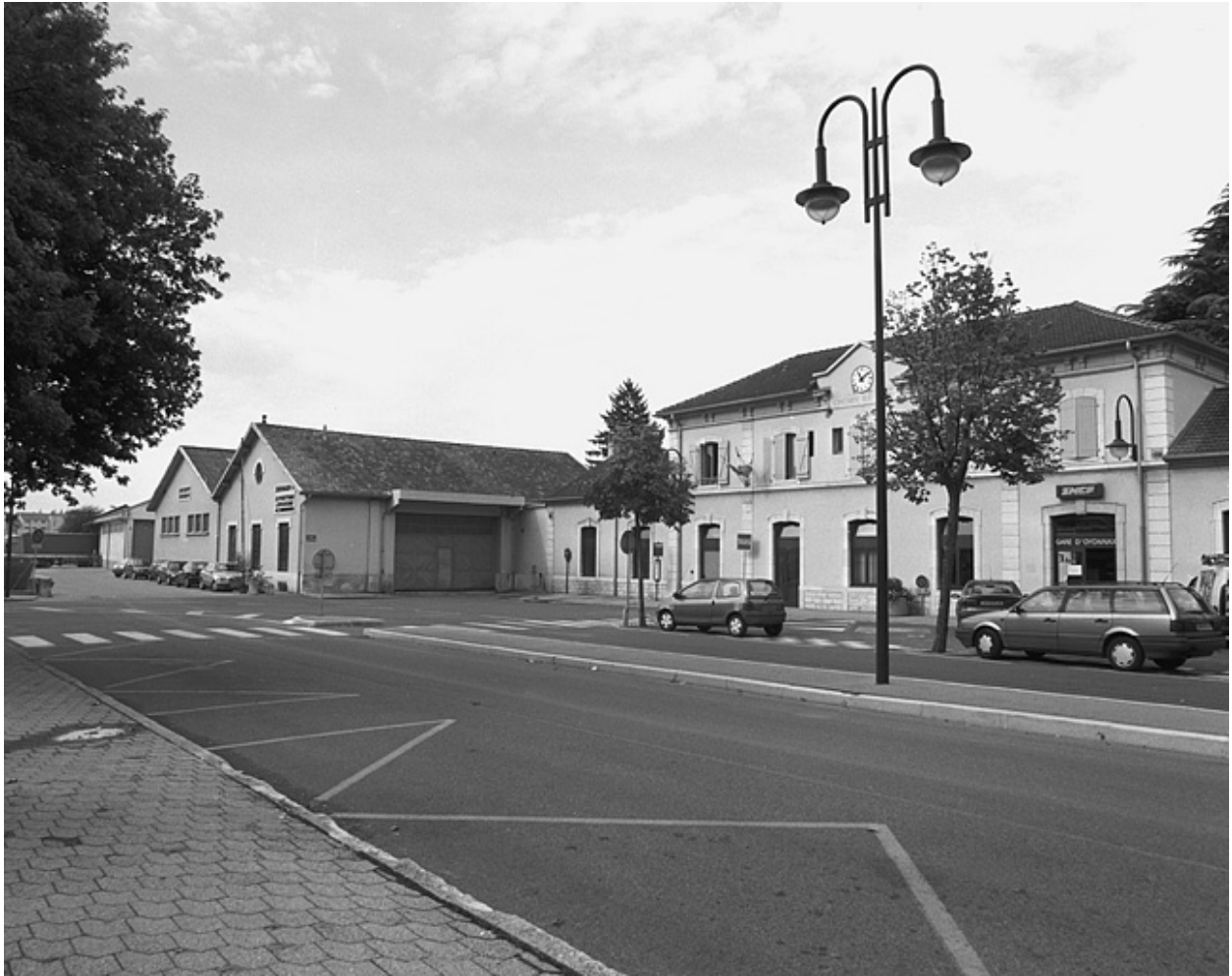
Entrepôts et cour, depuis le nord-est.
