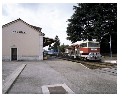
Bâtiment des voyageurs : extrémité nord, avec autorail RGP 1 (X 2733) et draineuse. Phot. Yves Sancey IVR43_20050100083XA
