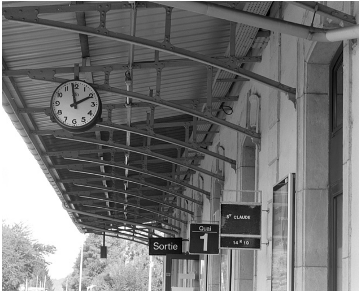
Bâtiment des voyageurs : consoles métalliques de l'auvent et horloge.
