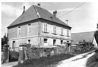
Presbytère situé rue de l'Eglise. Phot. Yves Sancey IVR43_19802500928X
