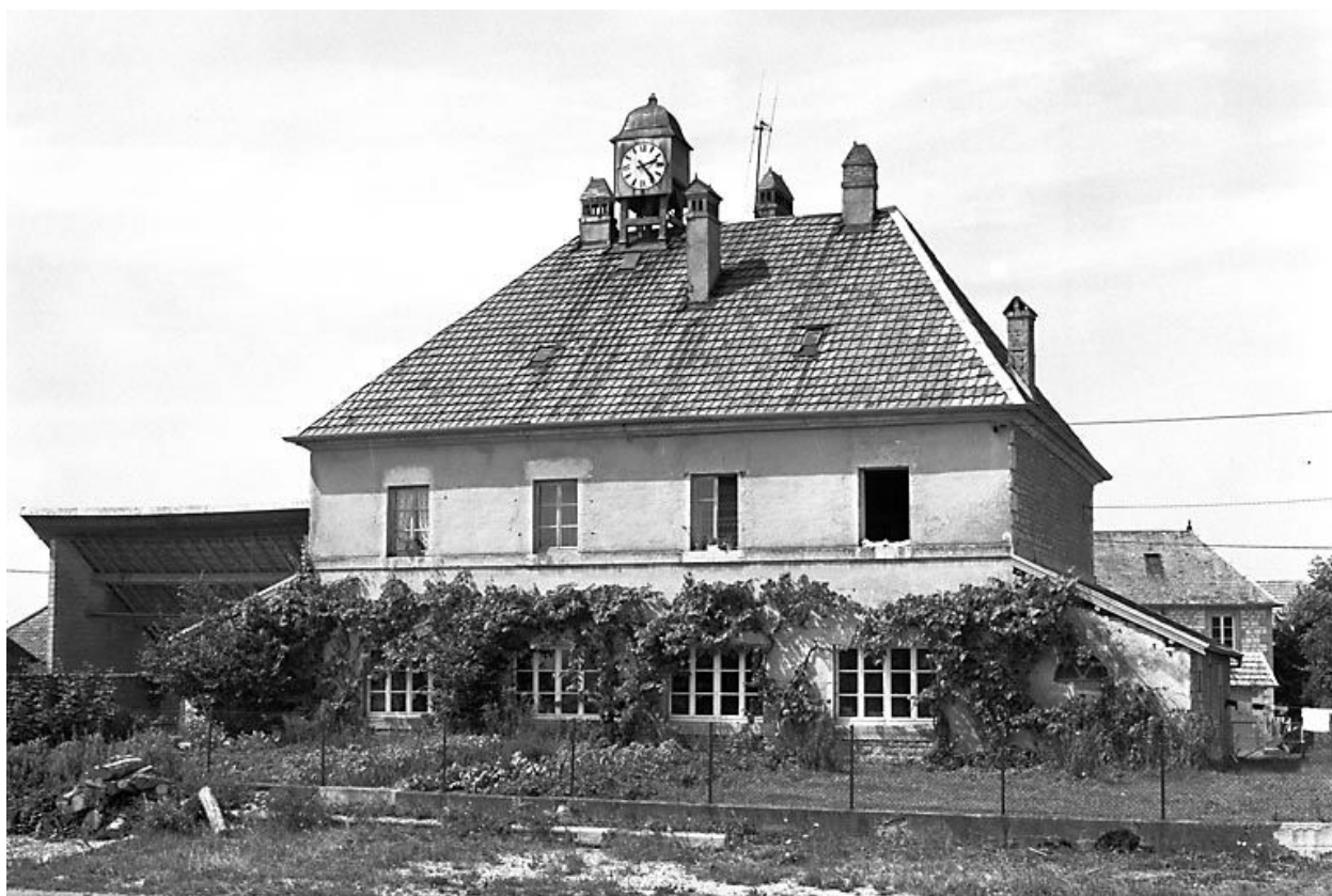
Ecole située rue de la Bascule.
