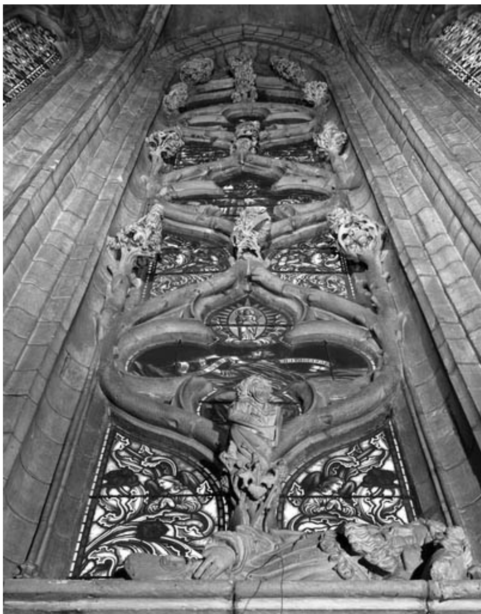
Vue d'ensemble en contre-plongée.
