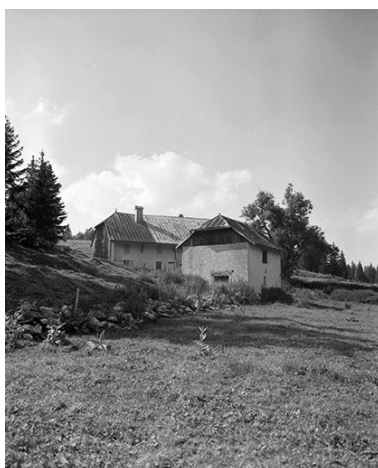
Ferme située au lieudit Pré Poncet : vue d'ensemble. Phot. Yves Sancey IVR43_19782500415X
