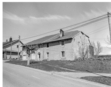
Ferme située Grande Rue : vue d'ensemble. Phot. Dominique Dominguez IVR43_19792500065X
