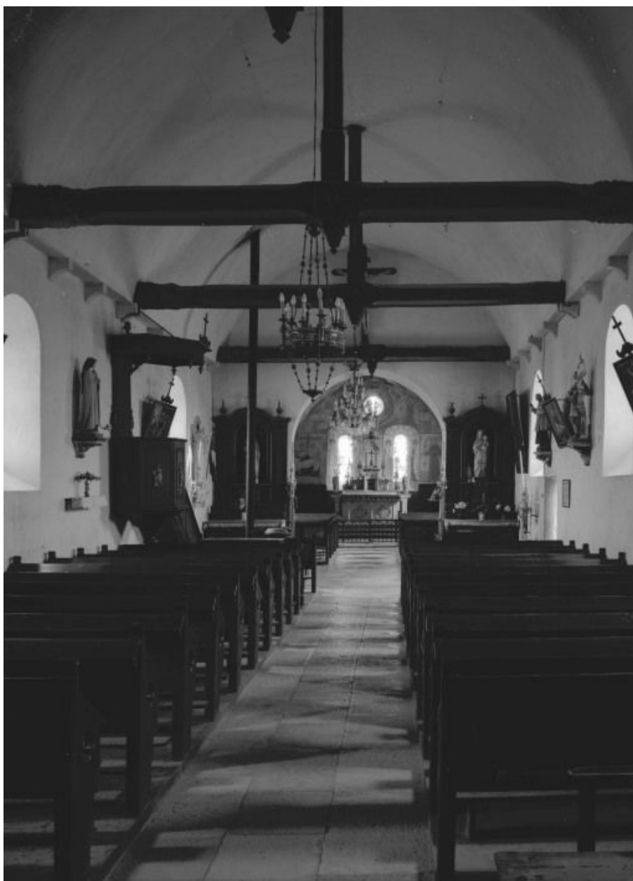
Vue intérieure prise de l'entrée
