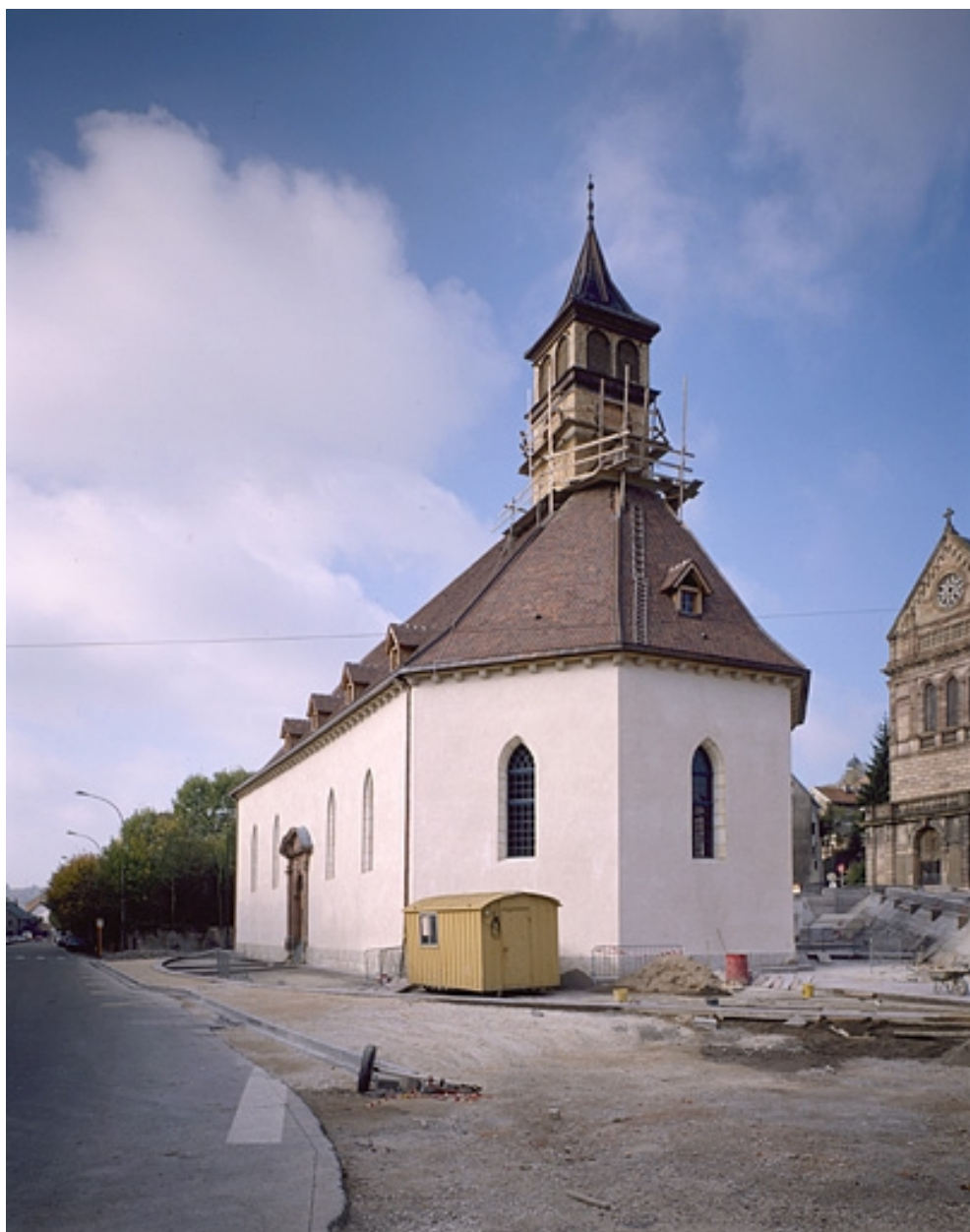
Vue d'ensemble des faces est et sud.
