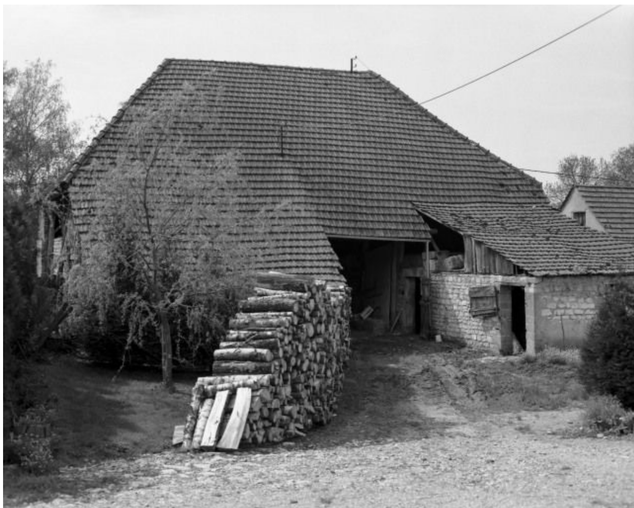
Grange de la ferme (cad. 1984, sect. AB, parc.149).
