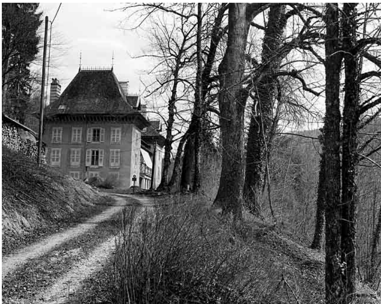
Vue d'ensemble rapprochée, depuis l'ouest.
