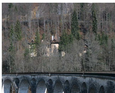
Vue d'ensemble rapprochée, depuis le sud-est. Phot. Yves Sancey IVR43_20053900520XA
