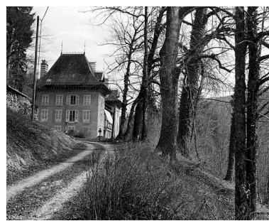
Vue d'ensemble rapprochée, depuis l'ouest. Phot. Yves Sancey IVR43_20053900534X
