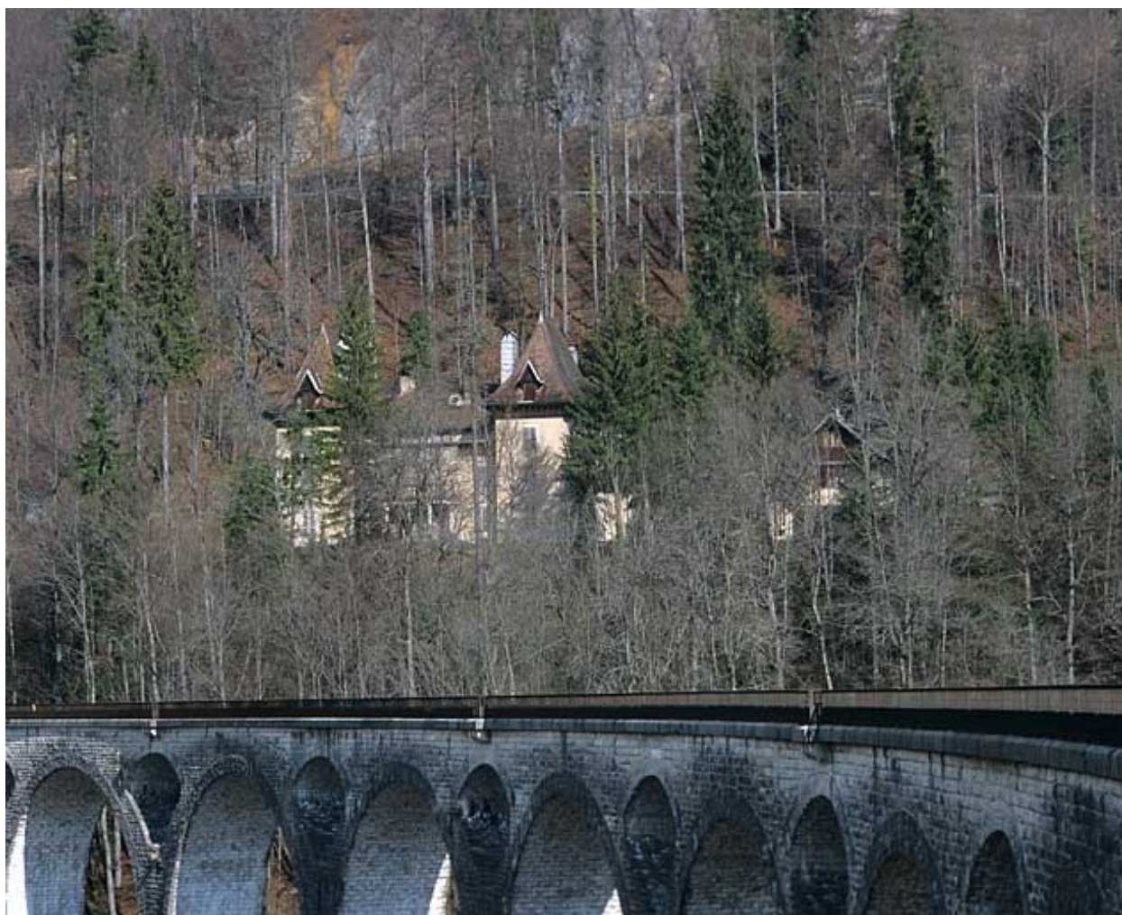
Vue d'ensemble rapprochée, depuis le sud-est.
