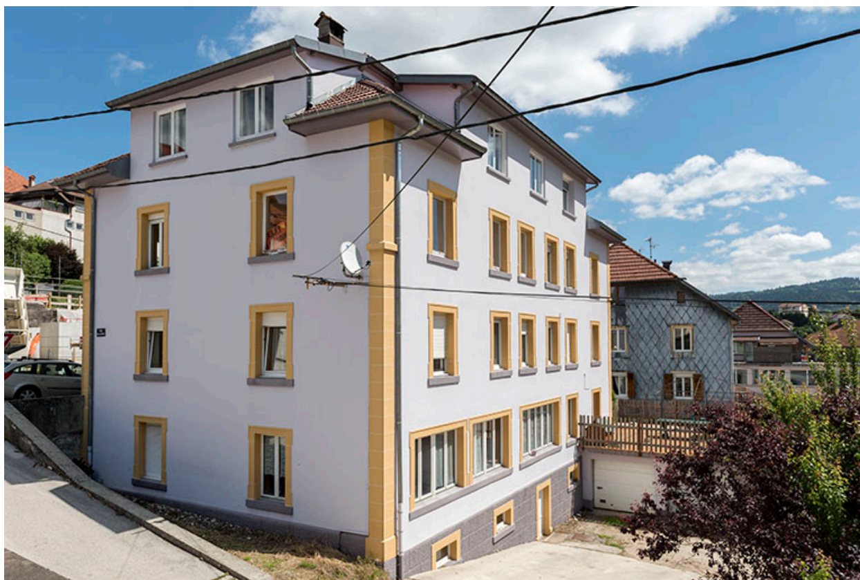
Façades postérieure et latérale droite.
