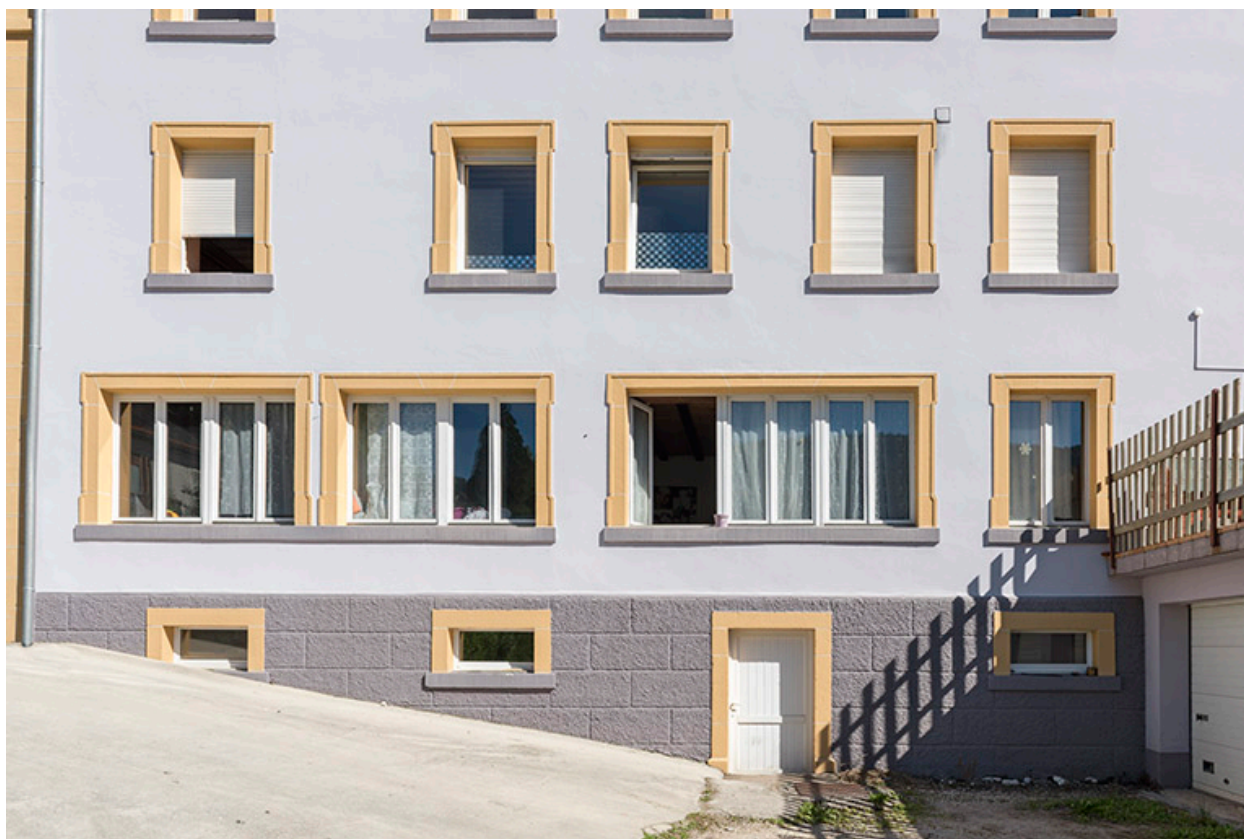
Façade postérieure : baies d'atelier.
