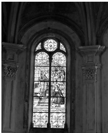
Baie 0 : vue d'ensemble. Phot. Jean-Luc Ligier IVR43_19812500687X
