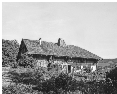
Façade latérale droite, en 1976. Phot. Dominique Humbert IVR43_19762500447X
