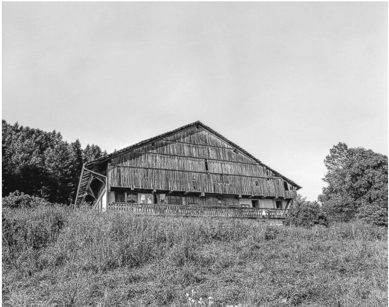
Façade postérieure, en 1976.
