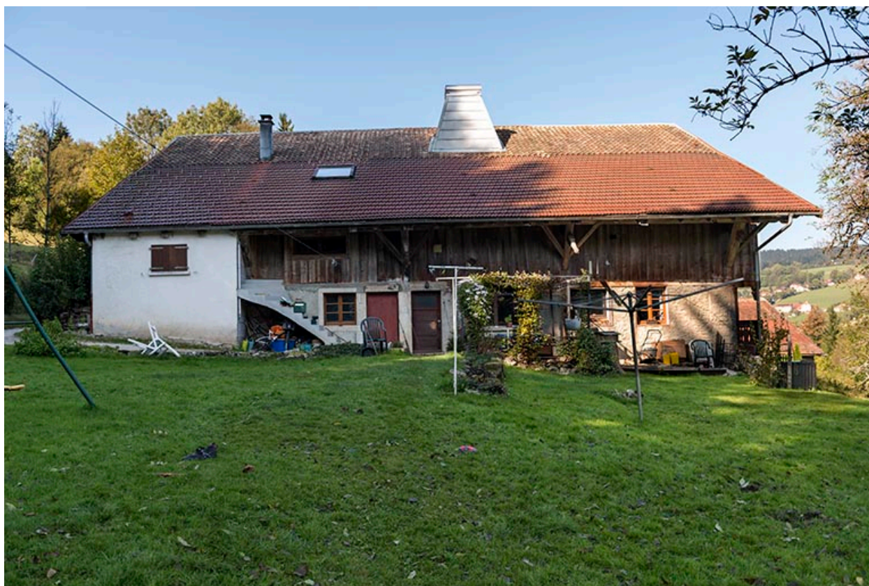
Façade latérale droite.
