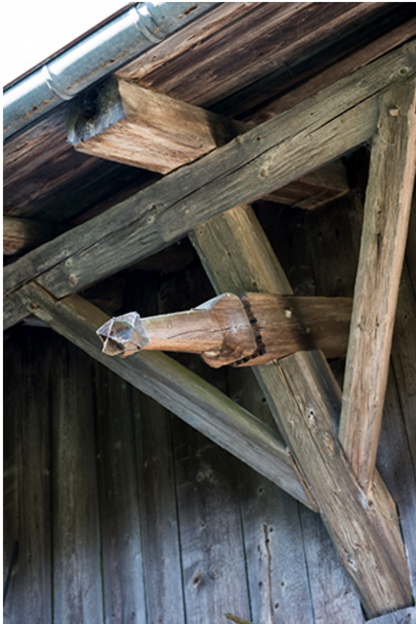
Façade latérale droite : extrémité de pièce de charpente sculptée.
