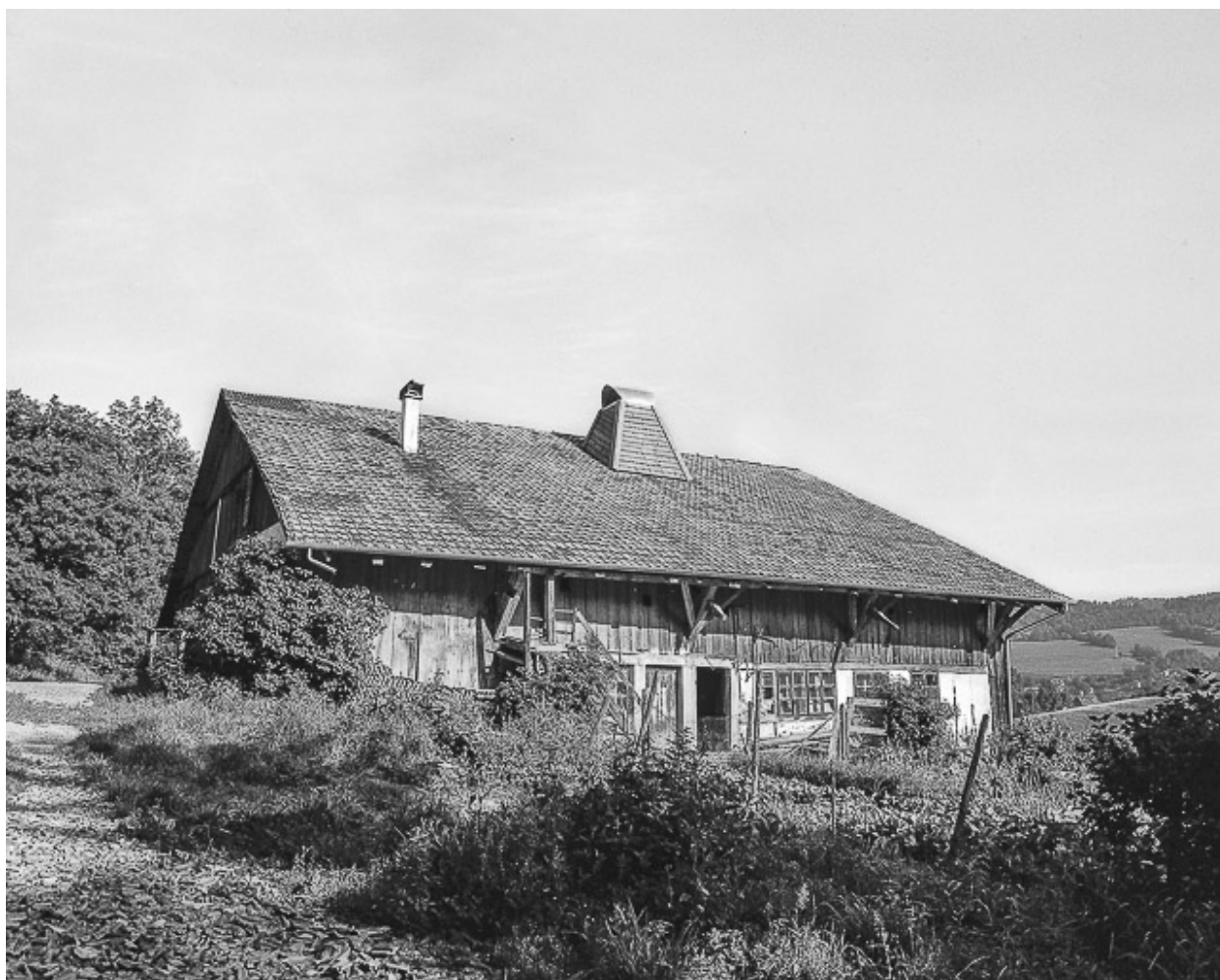
Façade latérale droite, en 1976.
