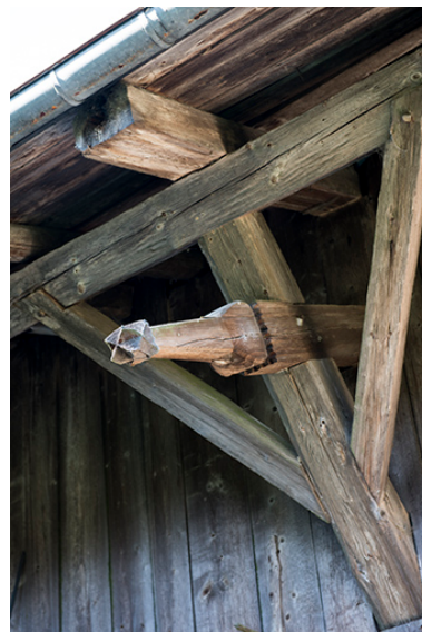
Façade latérale droite : extrémité de pièce de charpente sculptée. Phot. Sonia Dourlot IVR43_20162501410NUC4A
