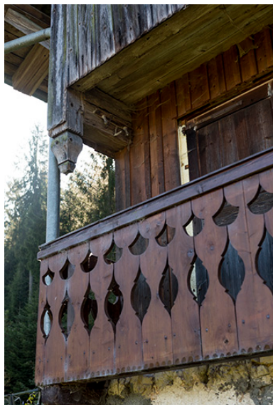
Façade postérieure : détail du garde-corps. Phot. Sonia Dourlot IVR43_20162501408NUC4A
