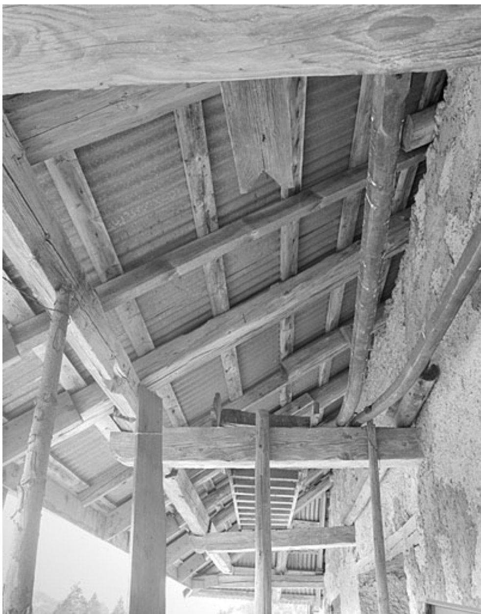
Détail de la charpente de l'avant-toit.
