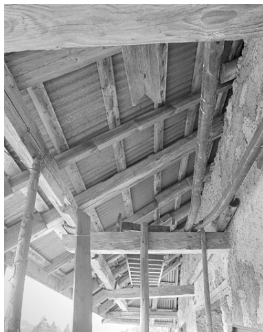
Détail de la charpente de l'avant-toit. Phot. Jérôme Mongreville IVR43_19963901541X
