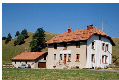
Façade antérieure et face droite de la fromagerie, à gauche la porcherie. Phot. Laurent Poupard IVR43_19903900415ZA
