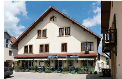
Ancienne ferme et atelier Seguin. Phot. Sonia Dourlot IVR43_20182500938NUC4A
