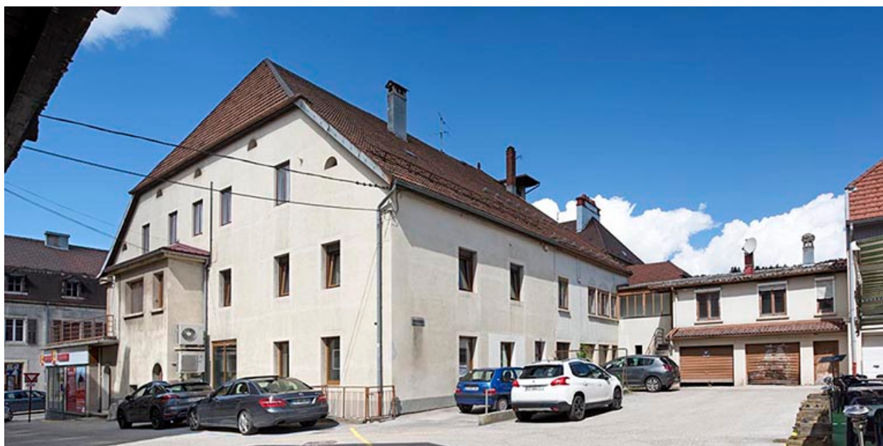
Maison : façades latérale droite et postérieure.
