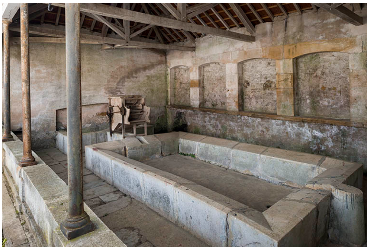
Vue intérieure de l'édifice.
