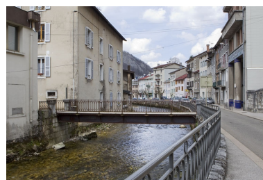
Vue d'ensemble, depuis l'amont. Phot. Yves Sancey IVR43_20103900170NUC2A
