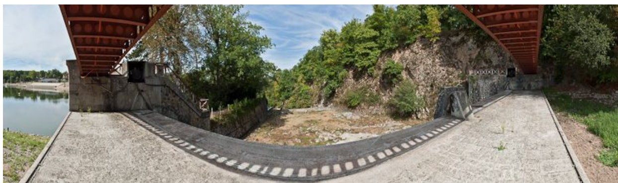
Vue du déversoir.
