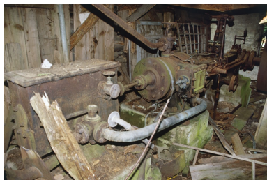
Vue d'ensemble de la machine à vapeur. Phot. Yves Sancey IVR43_20009000374ZA
