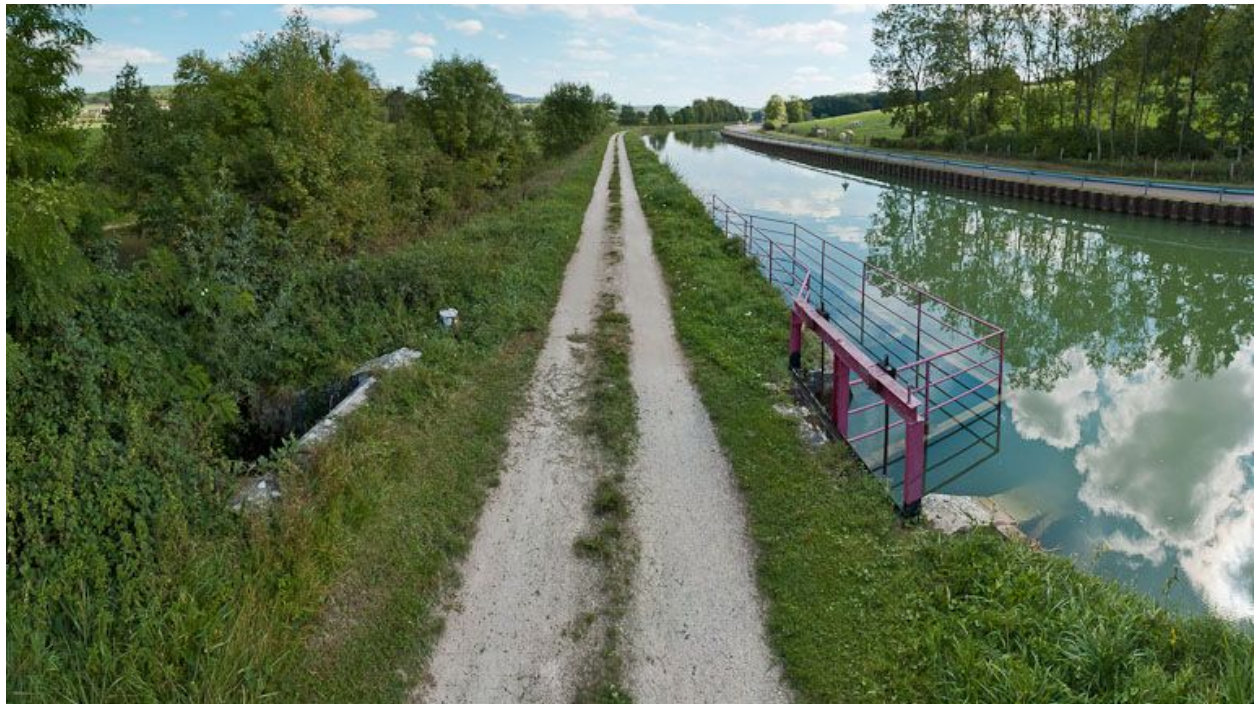
Vue du déversoir.
