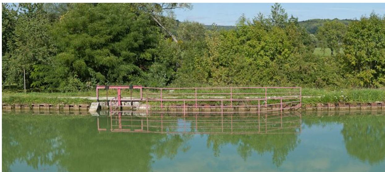
Vue du déversoir depuis la rive opposée.
