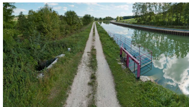
Vue du déversoir. Phot. Pierre-Marie Barbe-Richaud IVR26_20112104148NUC4AQ
