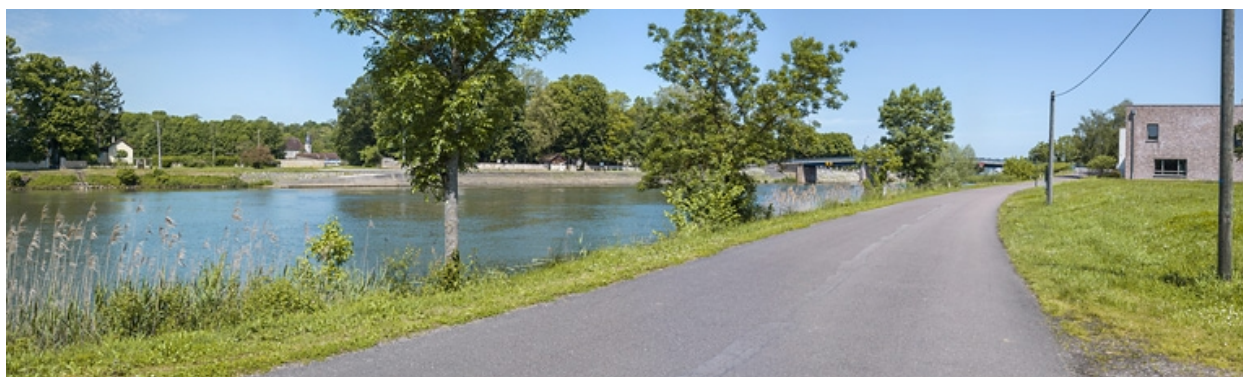
Vue d'ensemble depuis la rive gauche.
