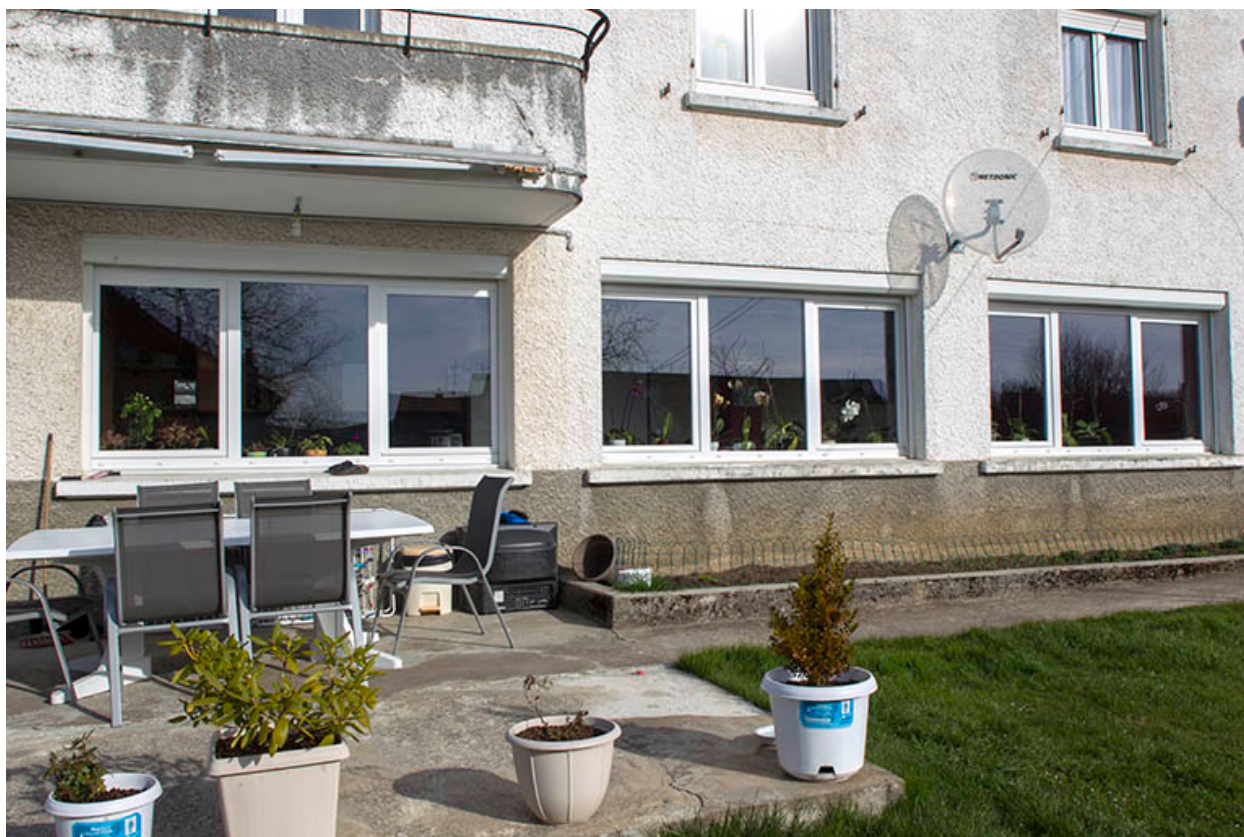
Façade postérieure : fenêtres de l'atelier.
